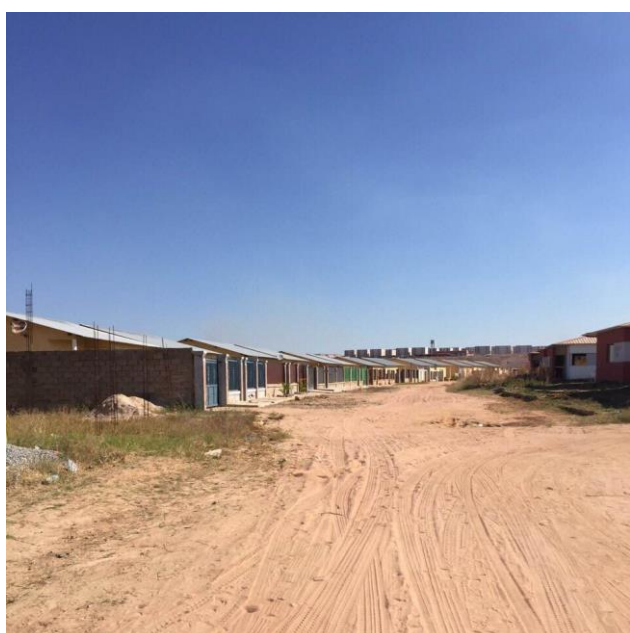
Figura 62 - Bairro do Lossambo no Huambo, 2016; Fonte: Autor
