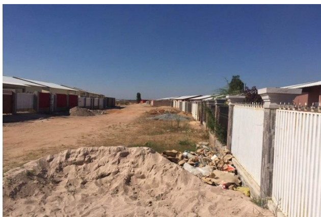
Figura 61 - Bairro do Lossambo no Huambo, 2016; Fonte: Autor
