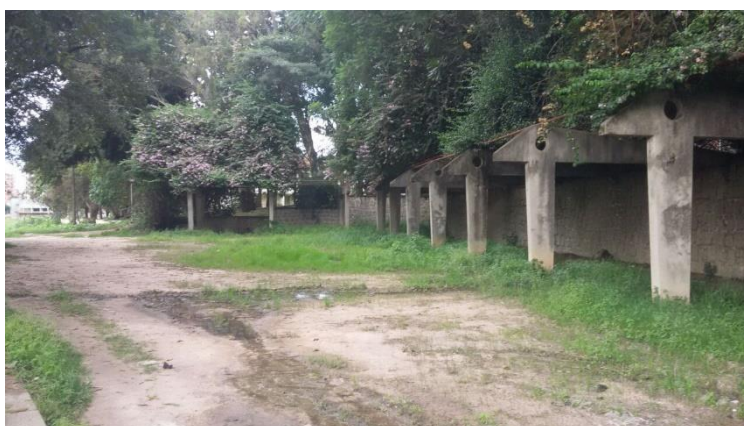
Figura 75 - Espaço em abandono da estufa-fria do Huambo, 2016; Fonte: Autor
