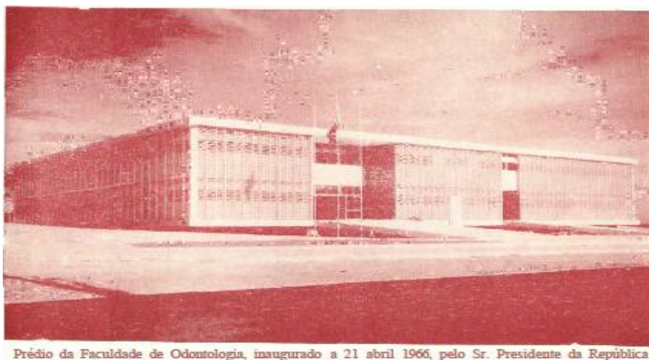
Figura 2 - Prédio da Faculdade de Odontologia, inaugurado em 21 de abril de 1966. Fonte: UFRN (1967).
