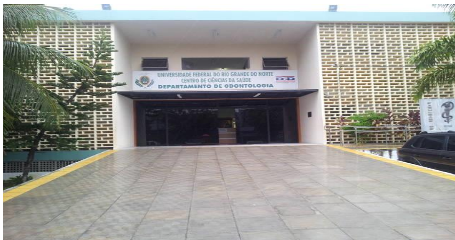
Figura 3 - Novas Instalações do Departamento de Odontologia da UFRN em 2008. Fonte: autora.
