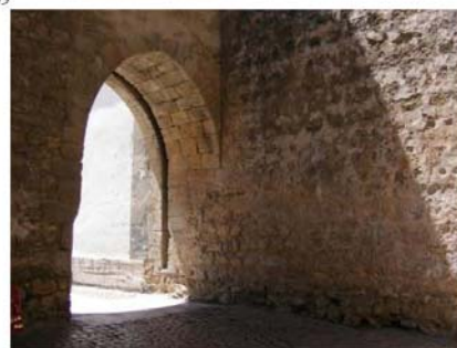
Figura 101 - [P26] Posta da vila, sentido exterior; Fonte: Autor, 2009
