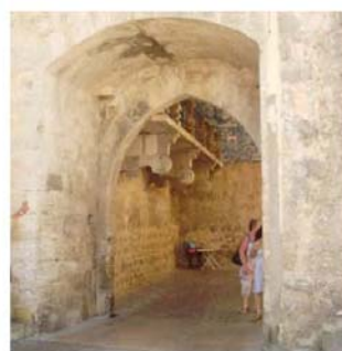
Figura 100 - [P25] Vista da porta da vila, interior; Fonte: Autor, 2009
