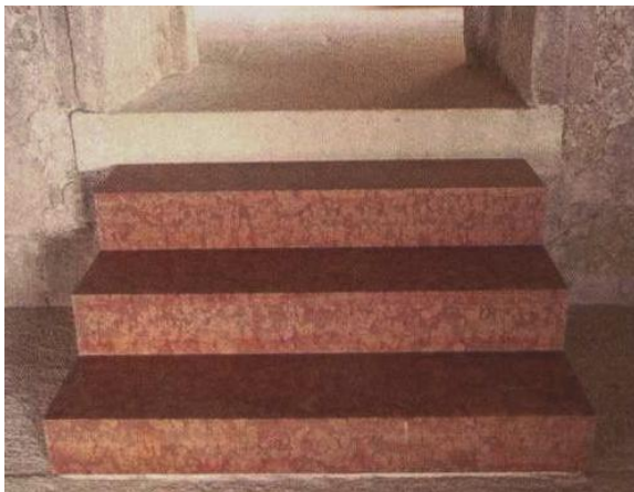
Figura 79: Escada em "bloco monolítico" de granito vermelho
