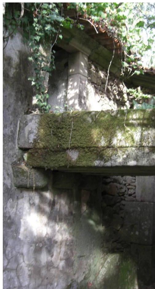
Figura 90: Passagem da habitação para a capela
