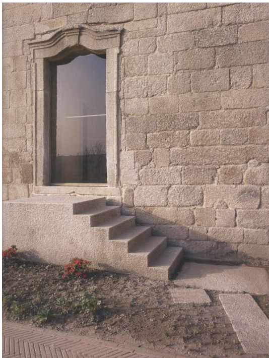
Figura 77: Escada em "bloco monolítico" de granito
