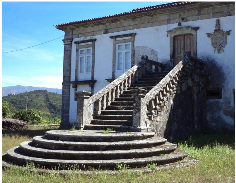
Figura 42: Escadaria e brasão da casa do Telhõ, Arnoia
