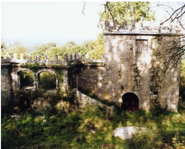
Figura 20: Torre de Aborim, Barcelos
