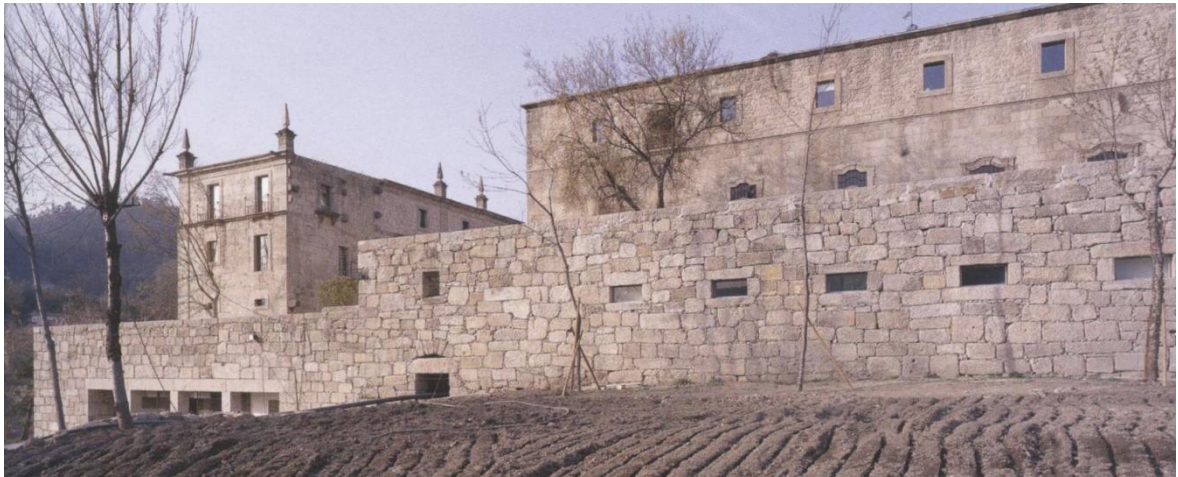
Figura 73: Vista traseira do convento
