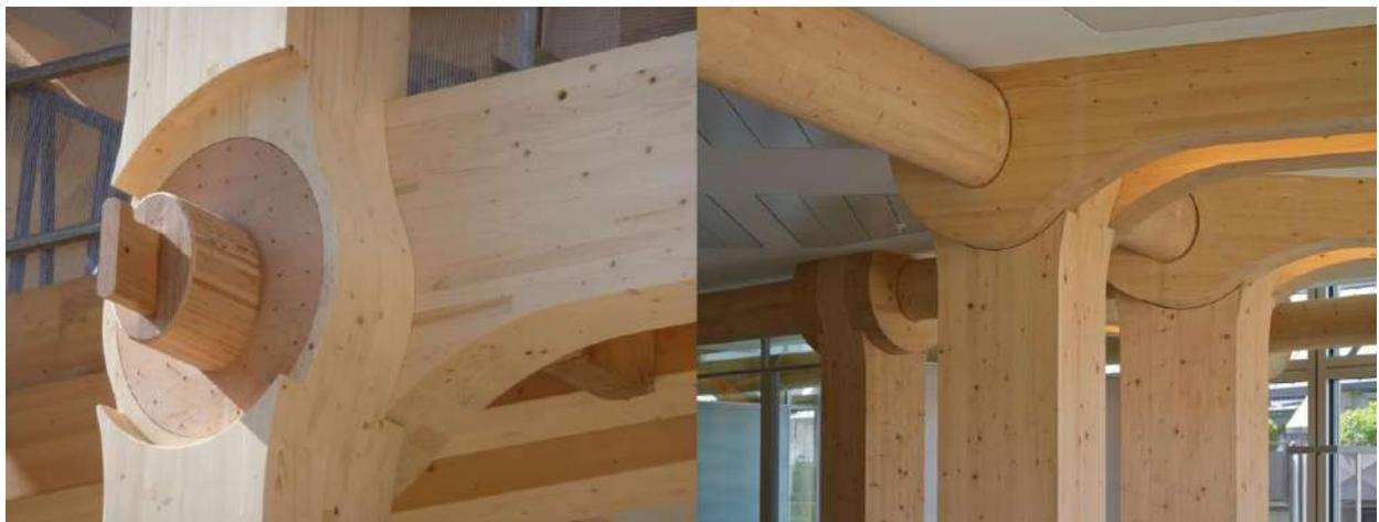
Imagem 60: Detalhamento construtivo do encaixe da viga em MLC no pilar em MLC, no projeto Tamedia Office Building. (fonte: Shigeru Ban Architects)
