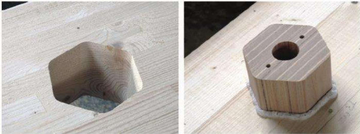
Imagem 27: Foto do conector hexagonal de madeira que faz a fixação das peças de MLC. (fonte: ADAPT Timber Project)
