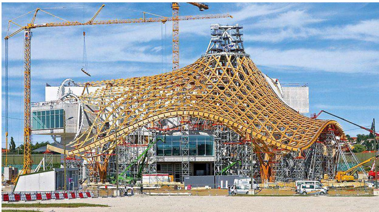
Imagem 24: Construção da estrutura da cobertura do Centre Pompidou. (fonte: Peri)
