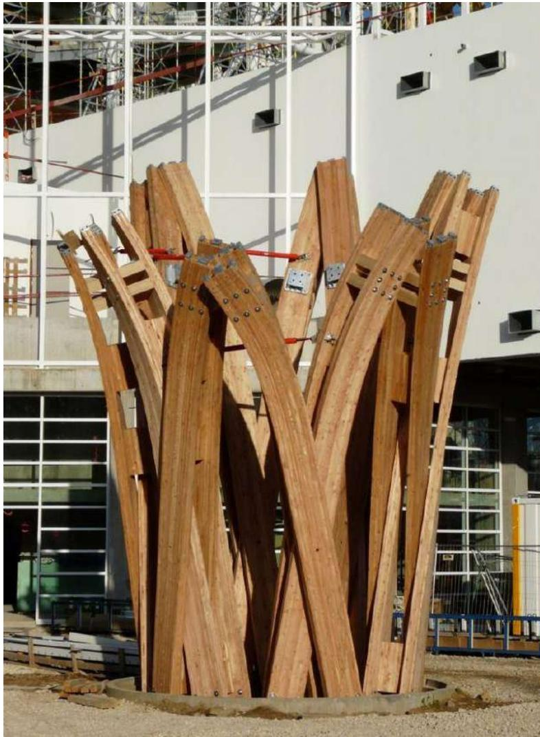
Imagem 26: Foto de um dos apoios da estrutura da cobertura. (fonte: Centre Pompidou Metz)
