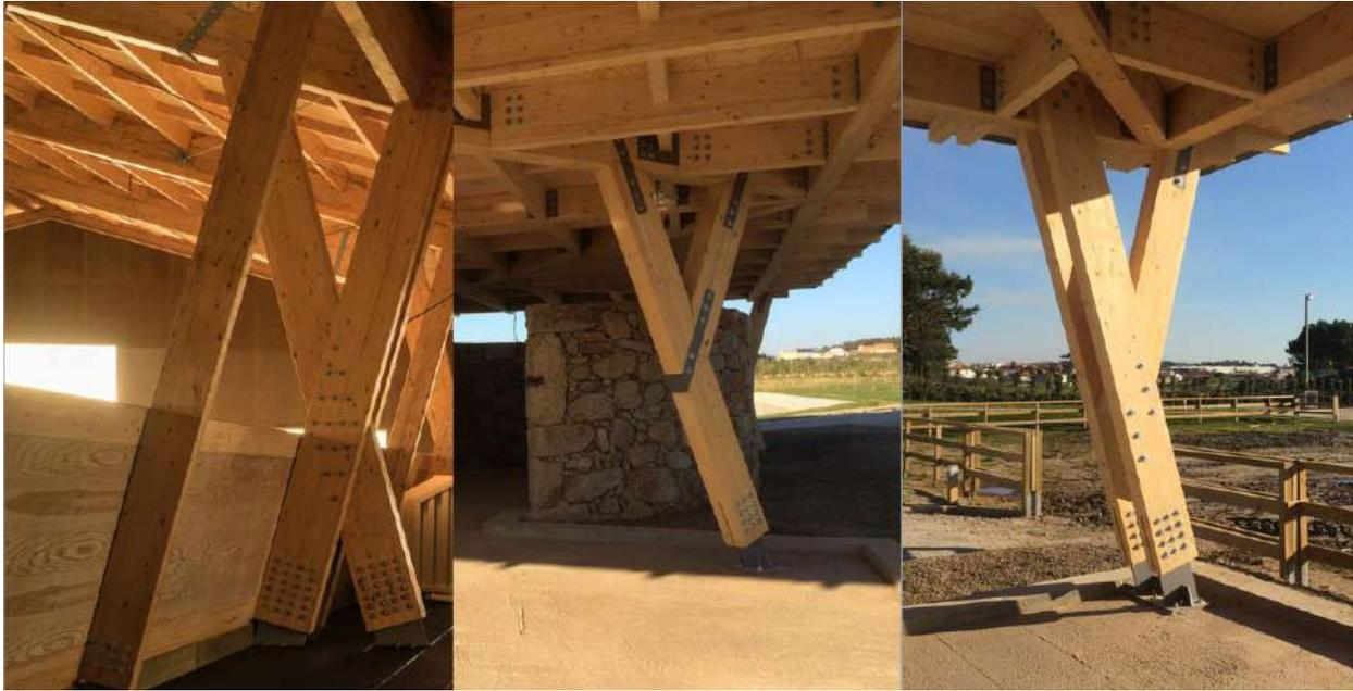
Imagem 15: Exemplos de pilares encontrados no projeto (da esquerda para a direita): pilar único, pilar composto em “X”, pilar simples em “Y”, e pilar composto em “Y”. (fonte: Carlos Castanheira; crédito: Fernando Guerra)
