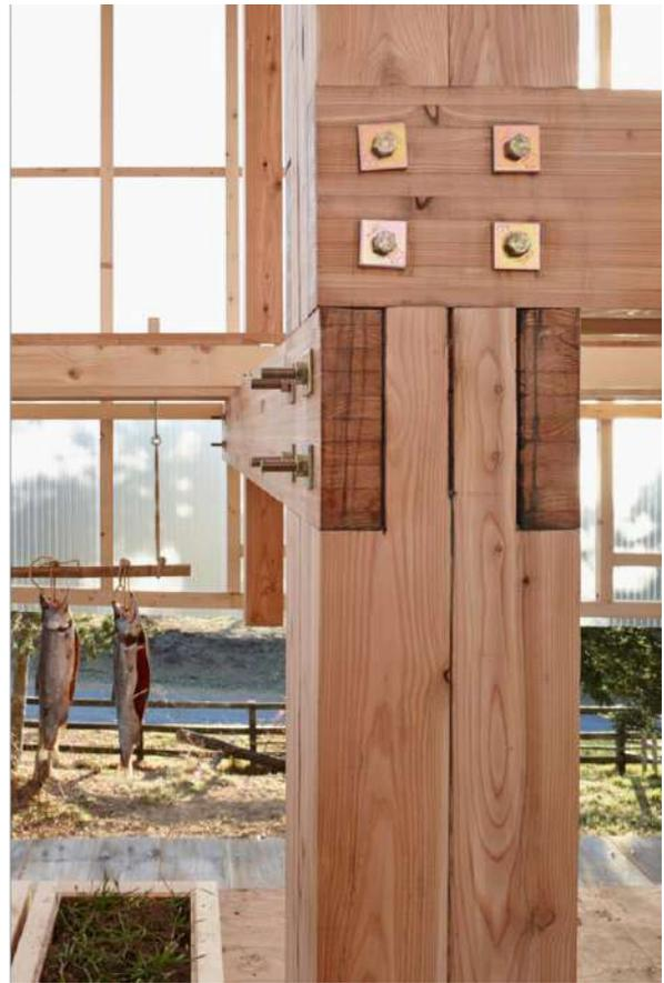
Imagem 59: Detalhamento construtivo do encaixe da viga em MLC no pilar em MLC, no projeto Nest We Grow. (fonte: KKAA; crédito: Shinkenchiku Sha)
