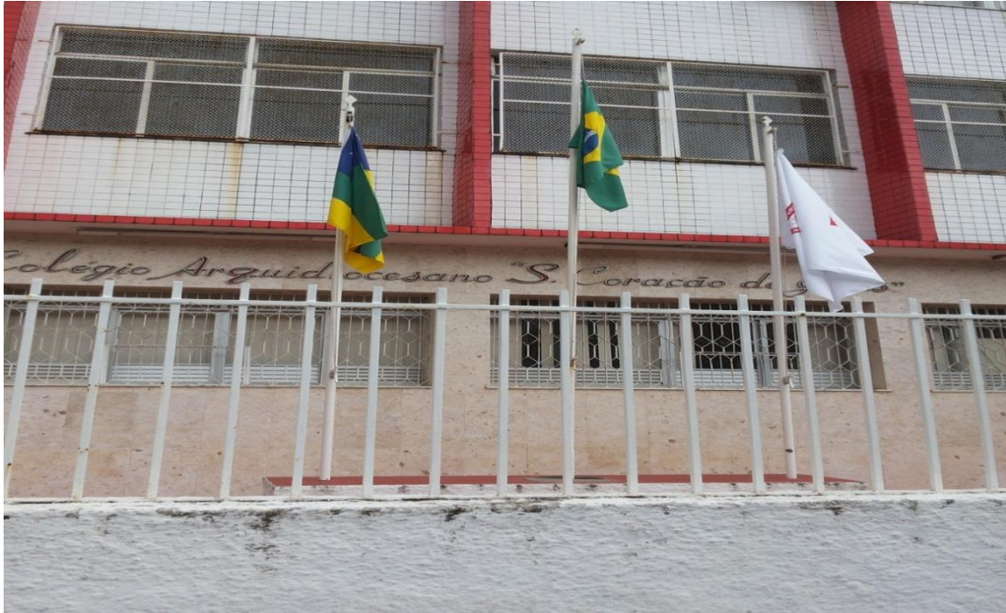
Foto nº 01 – Colégio Arquidiocesano de Aracaju – Fachada Externa
