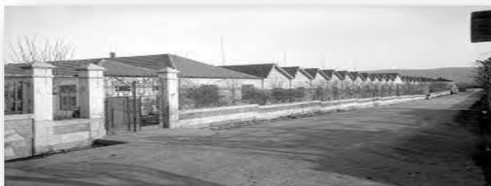
Figura 1 – Antiga fábrica têxtil de nome Salgueiros
