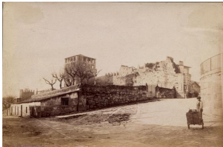
Figura 35. Muralha antes do restauro 1834
