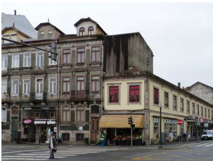
Figura 8. Fachada antes da Reabilitação
