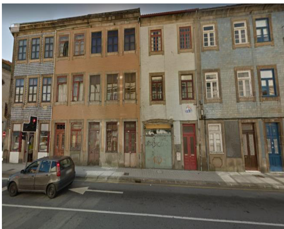
Figura 13. Fachada antes da Reabilitação
