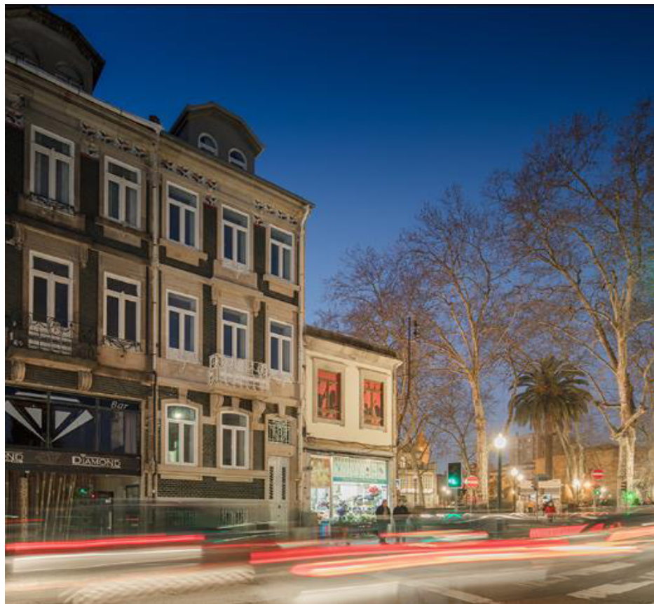
Figura 9. Fachada depois da Reabilitação Fonte: http://ooda.eu/work/santa-catarina/
