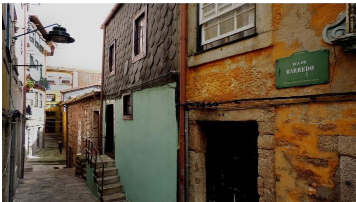
Figura 3. Porto, Rua do Barredo, área residencial popular reabilitada.
