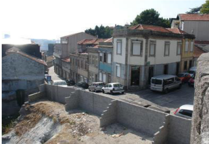
Figura 34. Fotos atuais da rua que desmoronou passeio das Fontainhas
