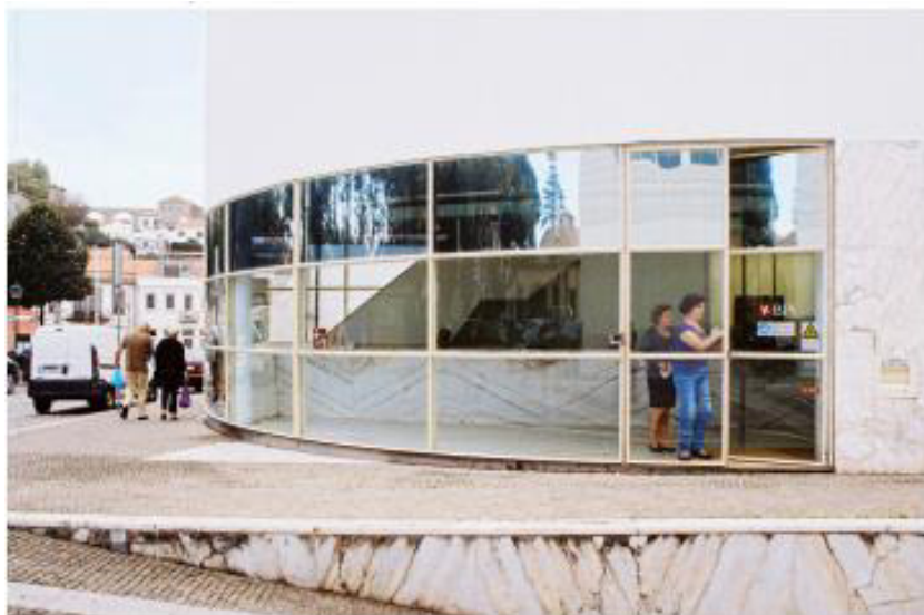
Figura 22. Detalhes da nova entrada do Banco
