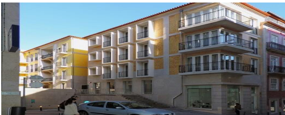
Figura 7. Porto, Passeio das Cardosas, edificações novas e renovadas, revestidas de novos materiais. Saída do estacionamento subterrâneo.
