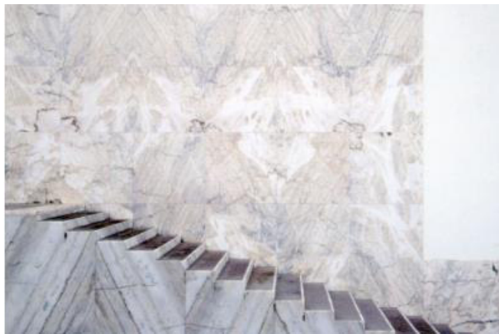
Figura 23. Detalhes em pedra na entrada dos acessos ao Banco.
