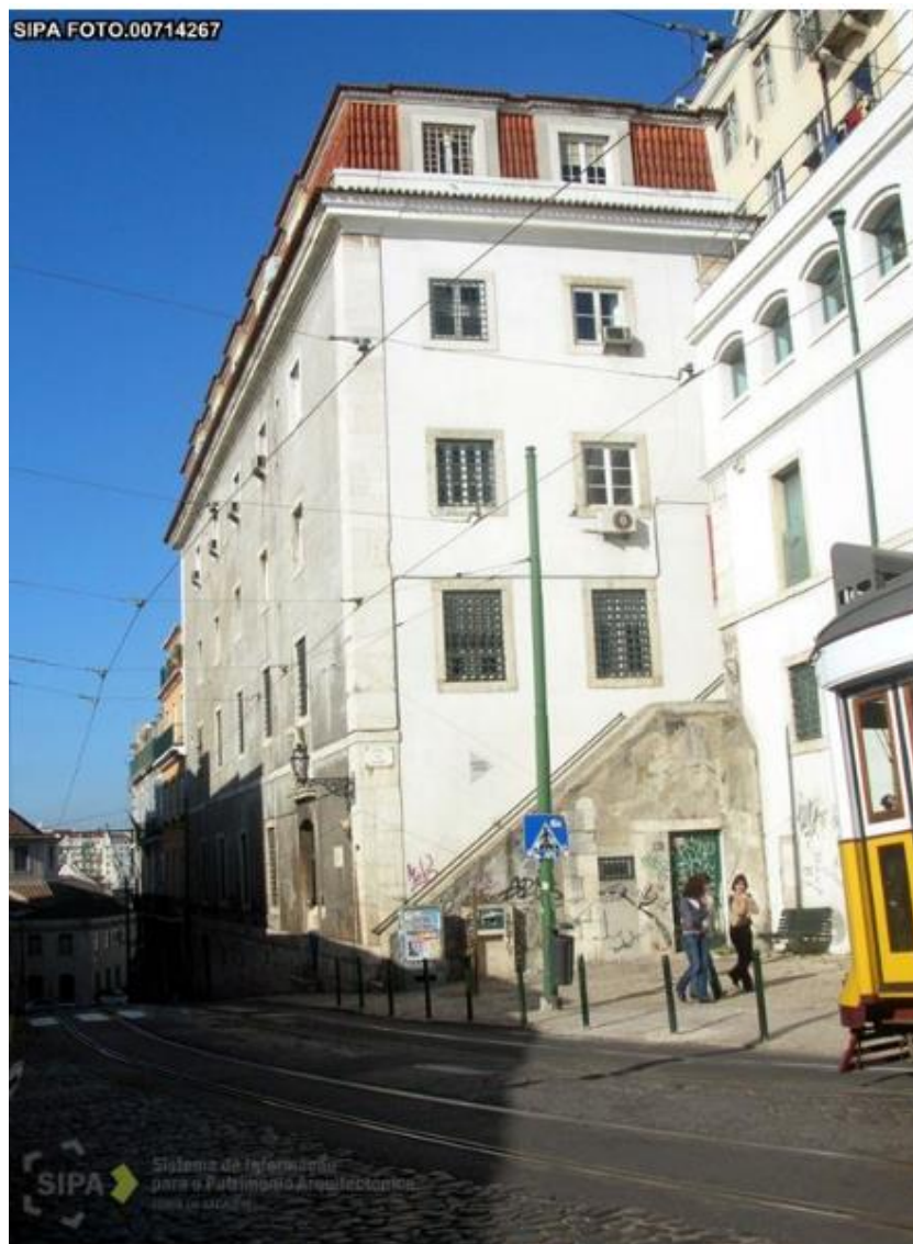
Figura 18 - Edifício do Museu do Aljube (www.monumentos.gov.pt, 2008).
