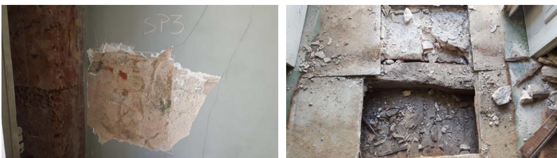
Figura 67 – Piso 2. Sondagem estrutural numa parede de alvenaria de pedra e no pavimento (A2P, 2019).
