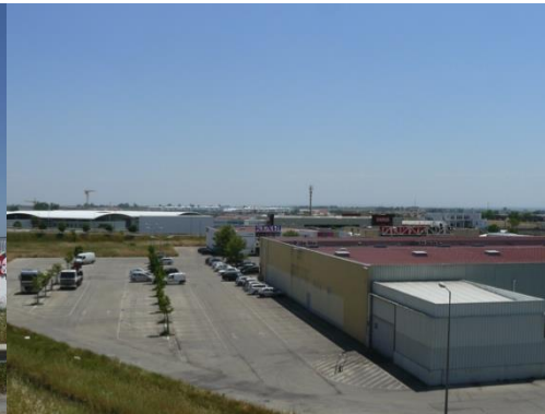
FIG. 6 – Impermeabilização do solo concretizada pelas áreas comerciais e estruturas de apoio.
