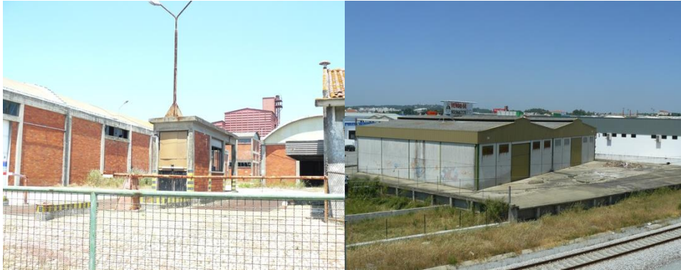
FIG. 7 – Exemplo de um espaço abandonado em processo avançado de degradação. FIG. 8 – Espaço comercial recentemente encerrado.
