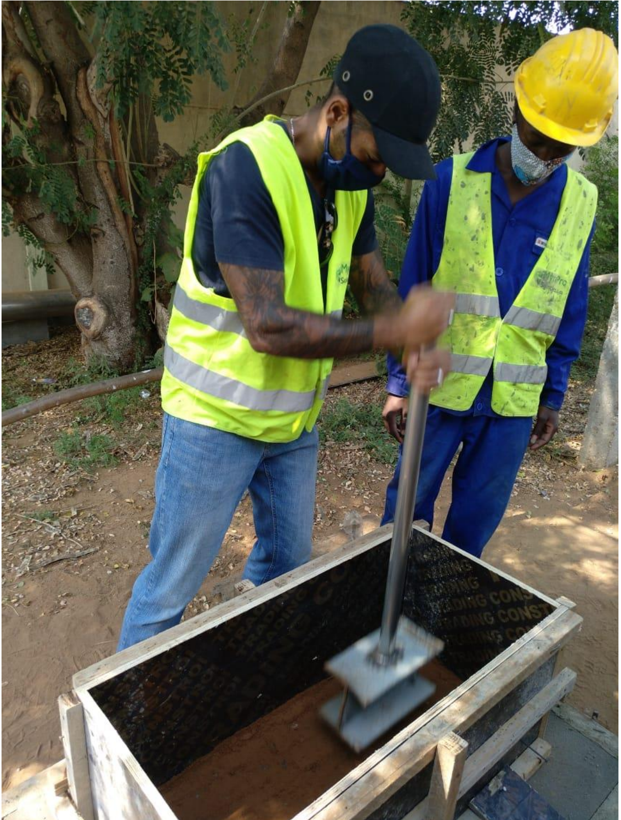
Fotografia 12 – Enchimento e compactação manual.
