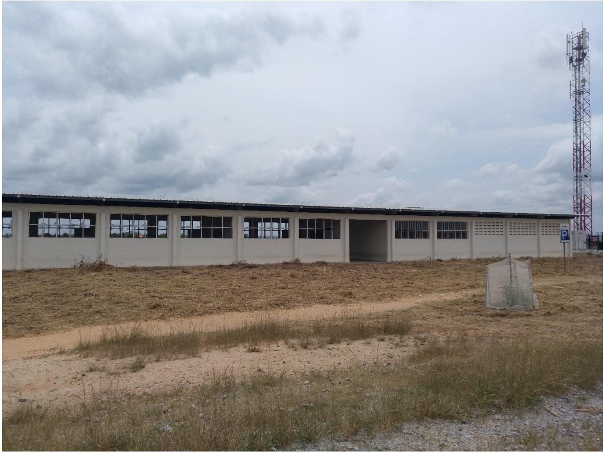
Fotografia 4 – Este edifício não está identificado, no entanto aparenta ser ou um centro de ofícios ou uma escola de 1º ciclo, porém apresenta graves sinais de vandalismo e abandono.
