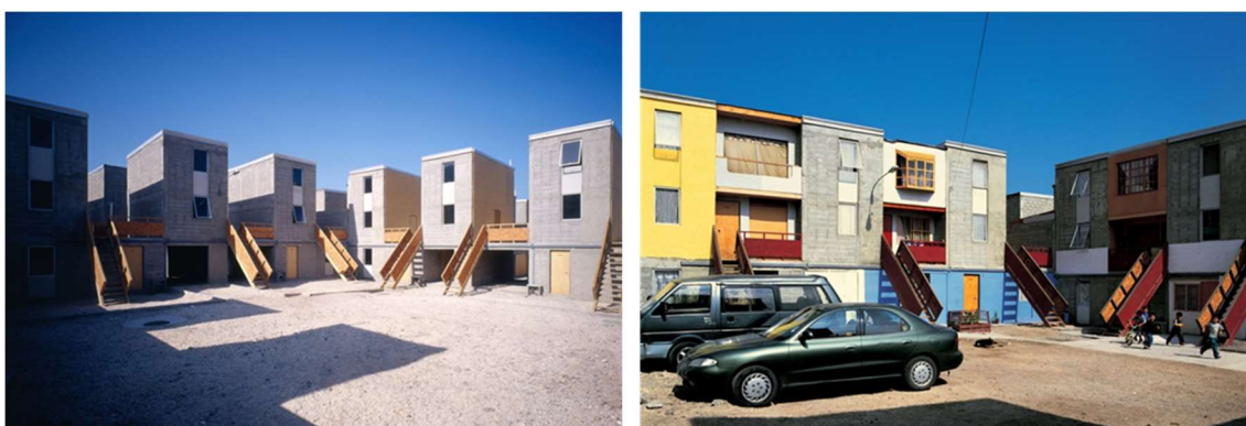
Fig. 6- Projecto Finalizado pelo Arquitecto, adaptação e auto-construção dos moradores consoante as necessidades.
