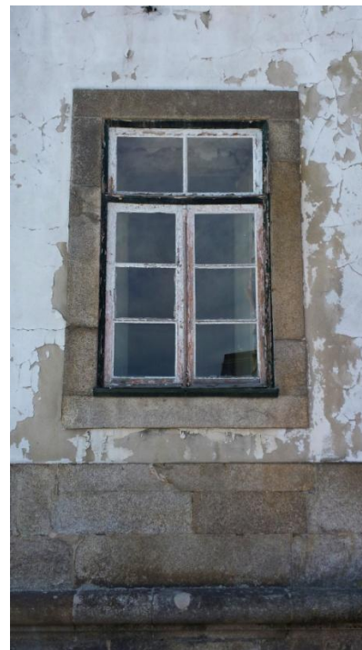
Fig.13– Janela de Batente e bandeira do Edifício do Governo Civil - Antiga Casa Pia
