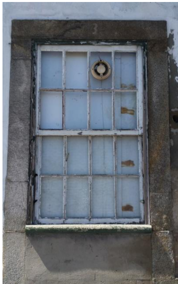
Fig.16 -Janela guilhotina do Edifício do Governo Civil - Antiga Casa Pia.
