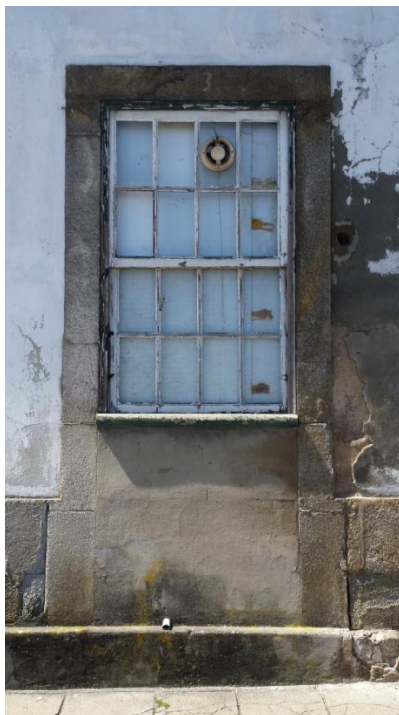
Fig.12– Janela de Guilhotina do Edifício do Governo Civil - Antiga Casa Pia
