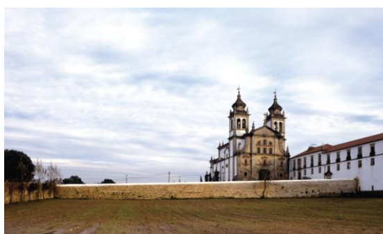
Fig. 20- Imagem exterior da Igreja e Mosteiro de Tibães.
