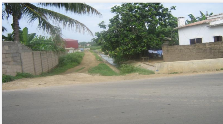
Figura 17 - Esgoto a céu aberto a desaguar na Baía Ana Chaves.
