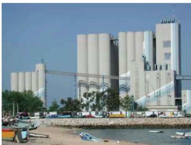
Figura 1 - Silo internacional de águas profundas (SIAP), na Trafaria.
