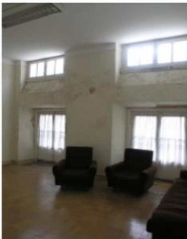
Figura 3.17 – Sala virada à Rua dos Sapateiros, “prédio 2”, (imagem do autor, 2019).
