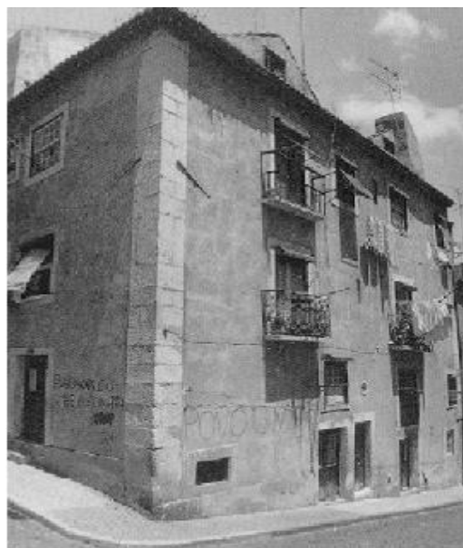
Figura 2.1 - Edifício pré-pombalino, localizado no Bairro Alto, Lisboa (LNEC, 2005).
