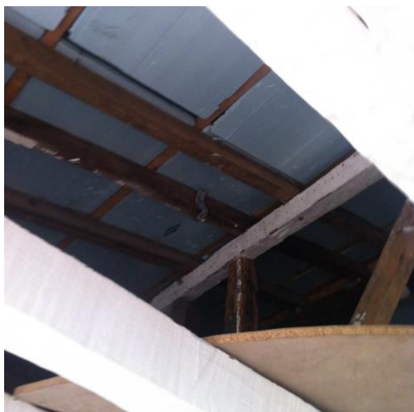
Figura 3.8 – Cobertura do edifício do Arco do Bandeira, (imagem do autor, 2019).
