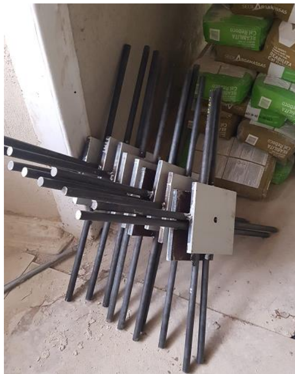
Figura 3.47 - Ancoragens dos cabos de pré-esforço, (imagem do autor, 2019).
