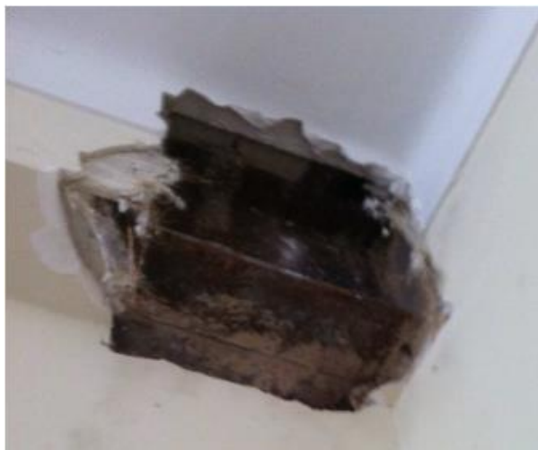
Figura 3.22 - Elemento de estrutura metálica no "prédio 2", (imagem do autor, 2019).
