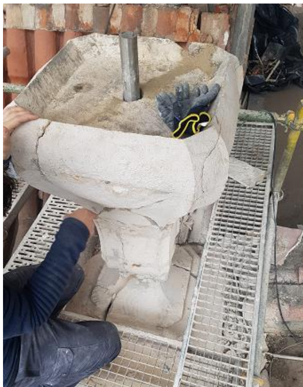
Figura 3.28 - Recuperação de coruchéu, (imagem do autor, 2019).
