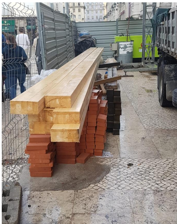
Figura 3.35 - Estaleiro da obra de reabilitação do Edifício do Arco do Bandeira, (imagem do autor, 2019).
