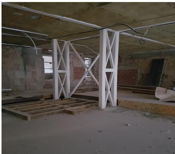
Figura 3.43 - Piso 1 com estrutura concluída, (imagem do autor, 2019).
