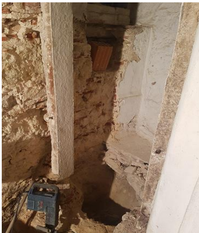
Figura 3.44 - Demolição na zona do elevador, (imagem do autor, 2019).
