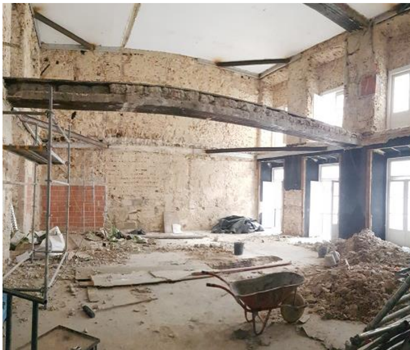
Figura 3.42 - Demolição "prédio 2" com escoramentos de canto executados, (imagem do autor, 2019).
