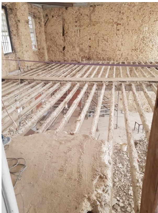
Figura 3.6 - Edifício do Arco do Bandeira, estrutura de pavimento “prédio 2”, (imagem do autor, 2019).
