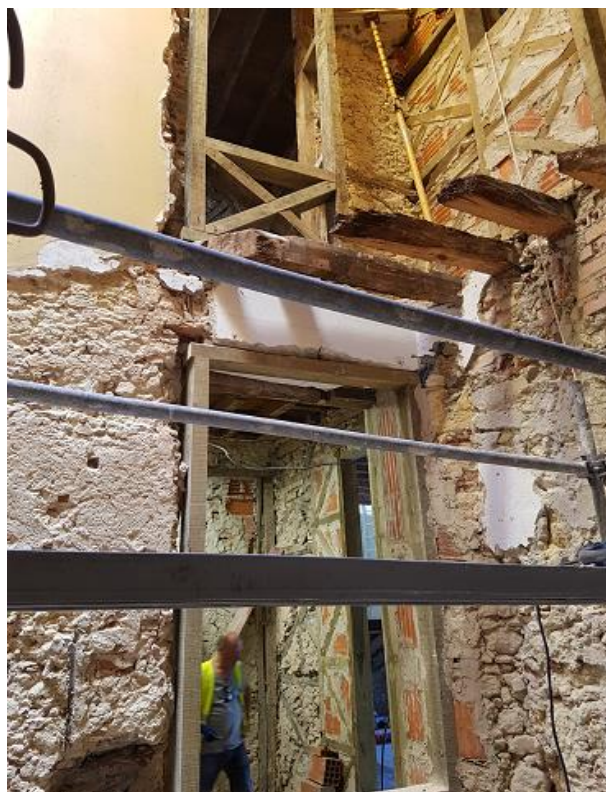
Figura 3.45 - Reconstrução de paredes no saguão interior, (imagem do autor, 2019).
