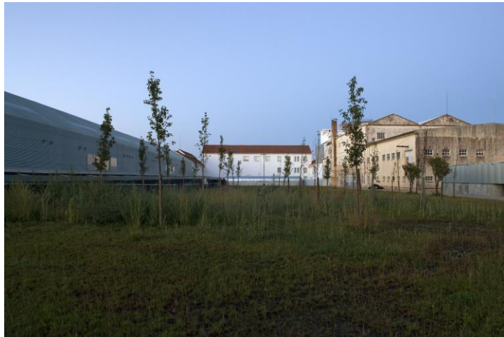
Fig. 44 – Vista interior, a partir do pátio do complexo após a intervenção.
