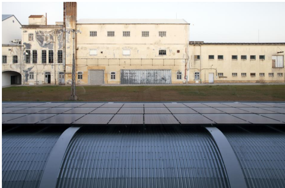
Fig. 51 – Vista para o pátio interior do complexo, a partir do novo edifício (C).
