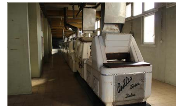
CAPTURA 6 - Empolamento da pintura - Paredes com vestígios de humidade e sujidade - Pavimento danificado e sujo - Caixilharia danificada
