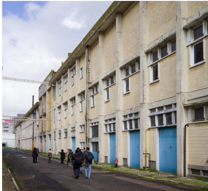
Fig. 54 – Vista da fachada poente da Fábrica de Massas e da Fábrica de Bolachas.
