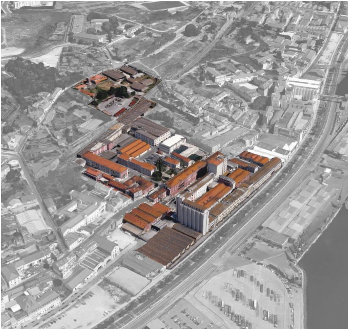
Fig. 1 – Vista aérea da Antiga Manutenção Militar de Lisboa, 2017.
