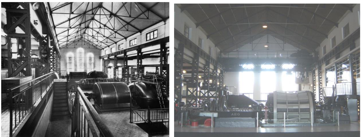
Fig. 29 e 30 – Vista interior da sala das máquinas, à esquerda antes da conversão e à direita na atualidade. Fonte: Restos de Coleção – Central Tejo (Consultado a 20/10/2017).
