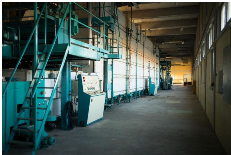
Fig. 59 – Interior do piso 1 da Fábrica de Massas – zona de fornos e empacotamento.
