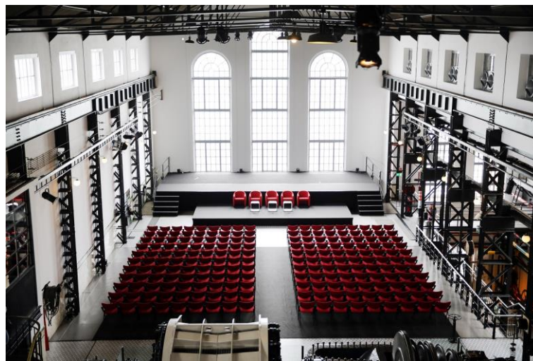
Fig. 32 – Sala dos geradores, após a conversão.
