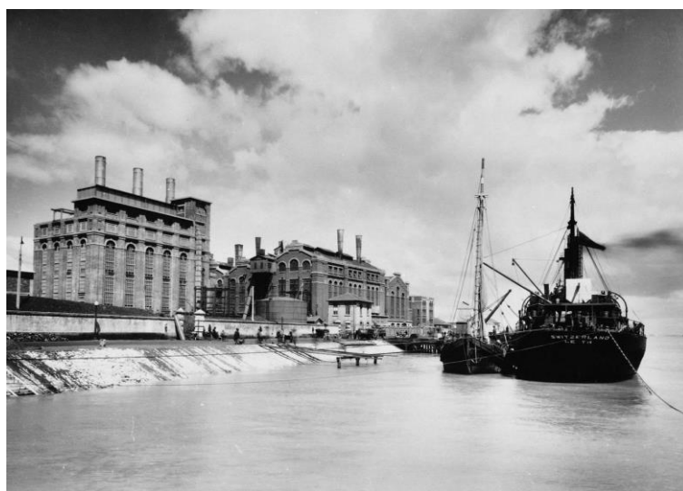
Fig. 27 – Descarregamento do carvão junto à central.
