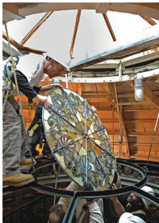
Figura 9 – Instalação de um óculo de vidro lapidado, em um domo de Healy & Millet. Foto: Neal A. Vogel - National Park Service, 2007.
