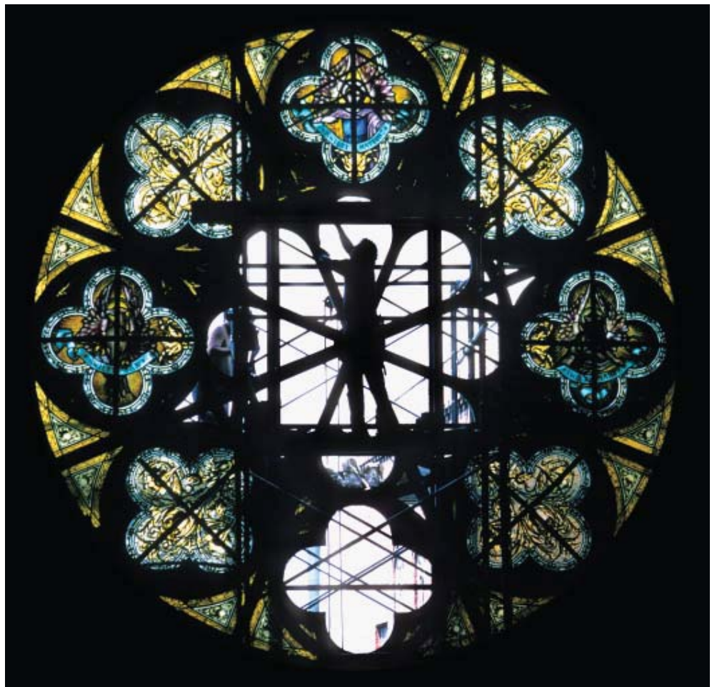
Figura 12 – Vista externa da moldura de madeira de uma rosácea em vitral, sob reparos. Foto: Neal A. Vogel - National Park Service, 2007.
