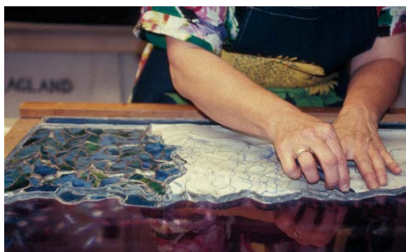
Figura 10 – Retirada do envidraçamento externo de um vitral Tiffany, para limpeza. Foto: Neal A. Vogel - National Park Service, 2007.
