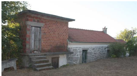
Figura 36: Casa de Estudo, fotografia do Alçado Oeste
