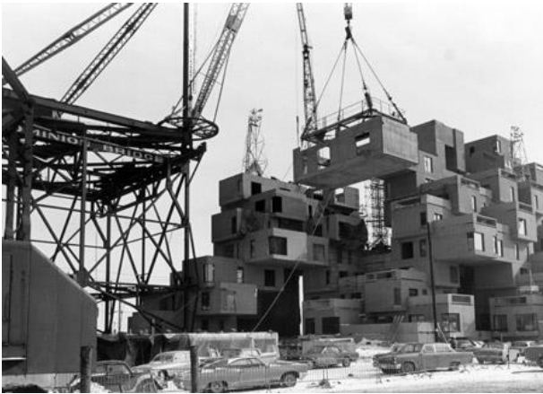
Figura 44 - Fase de construção habitat 67 (Merin, 2003)
