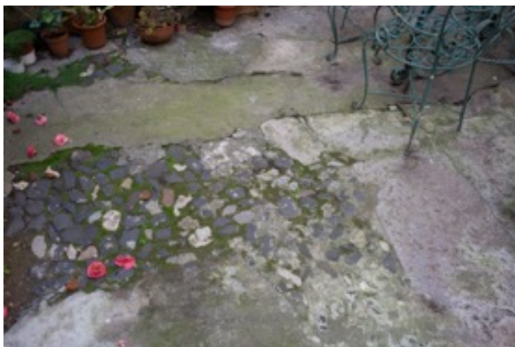
Figura 19. Pavimento do pátio interior vendo-se a sobreposição de vários materiais.
