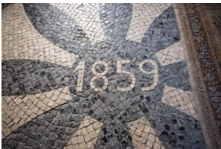
Figura 18. Pavimento do átrio de entrada em calçada à portuguesa com indicação da data de 1859, altura em que terá sido executado.
