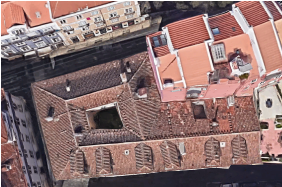
Figura 29. Vista aérea das coberturas do antigo Recolhimento das Mercceiras.
