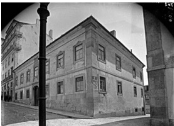
Figura 8. O Recolhimento das Merceeiras; fachada para a Rua Augusto Rosa; 1902.
