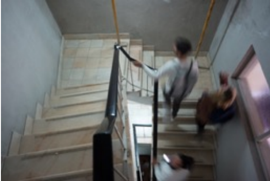
Figura 12. Escadas em betão armado, construídas para melhorar a ligação entre o piso térreo e os pisos elevados.
