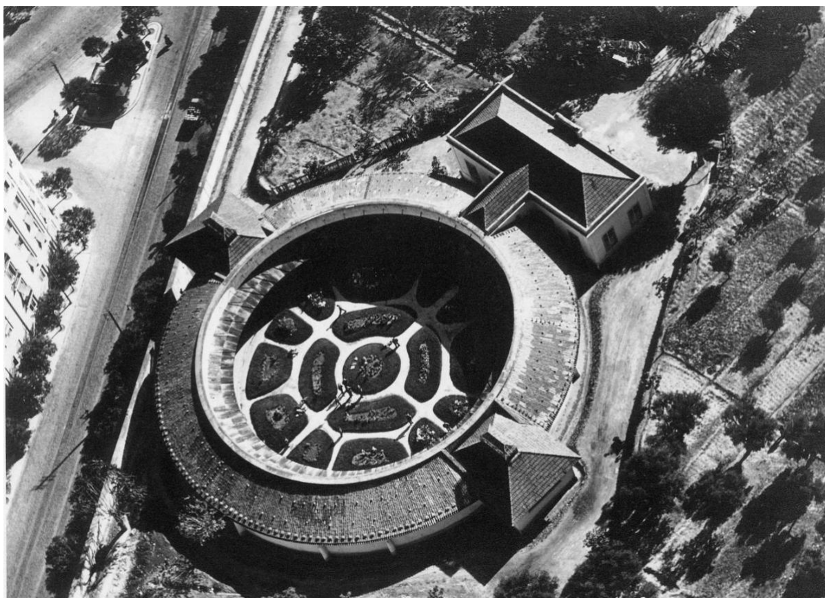
Figura 26 – Fotografia Aérea do Pavilhão de Segurança, HMB, Lisboa, 10 de novembro de 1948. Fonte: Freire, Vítor Albuquerque (2009). Panóptico, Vanguardista e Ignorado: O Pavilhão de Segurança do Hospital Miguel Bombarda . Lisboa: Livros Horizonte
