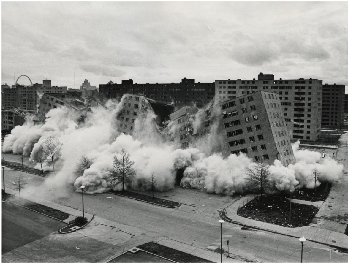
Figura 2 – Demolição do primeiro conjunto de edifícios, Pruitt-Igoe, St. Louis, Missouri, EUA, 1971. Fonte: www.archdaily.com
