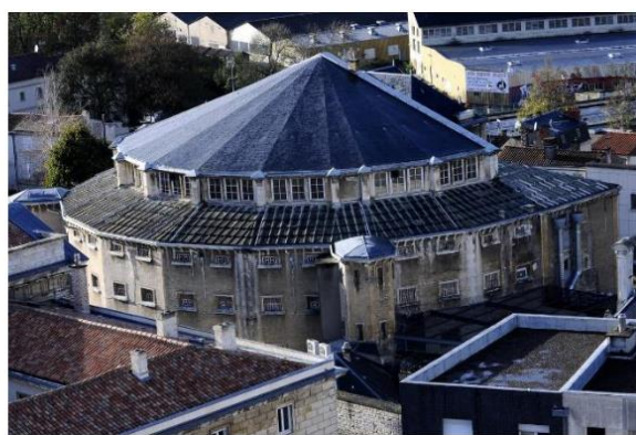
Figura 11 – Fotografia da Maison d'Arrêt, Niort, França, 2010 (ano de construção 1853). Fonte: www.lanouvellerepublique.fr
