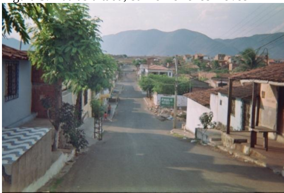
Figura 5: Rua asfaltada, bairro Terrenos Novos
