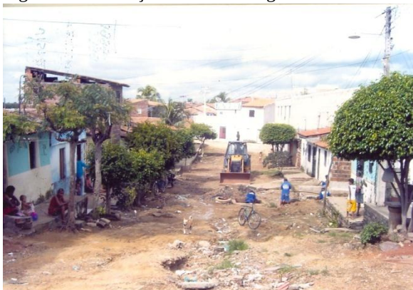
Figura 7: Construção da rede de esgotos no bairro
