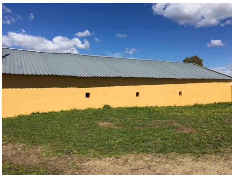
Figura 12 – Exploração C. Vista exterior do edifício de isolamento.
