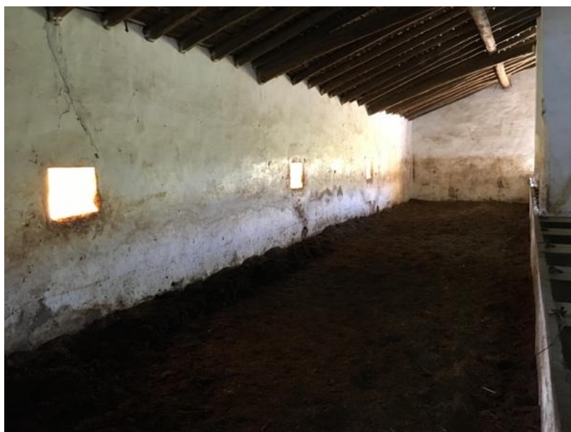
Figura 10 – Exploração C. Parque no interior do edifício de isolamento.
