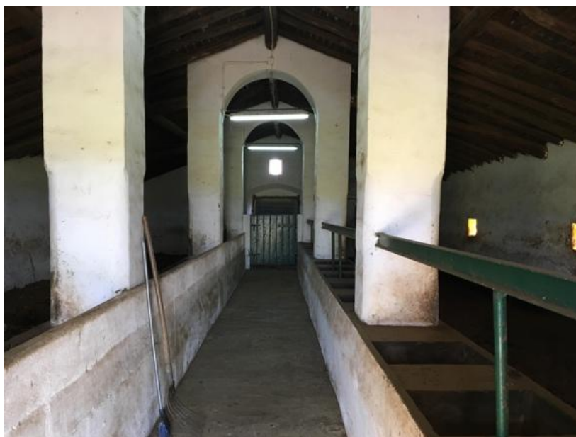
Figura 11 – Exploração C. Corredor no interior do edifício de isolamento.
