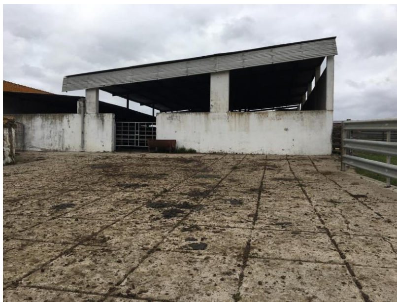
Figura 9 – Exploração F. Instalações destinadas ao isolamento dos animais.
