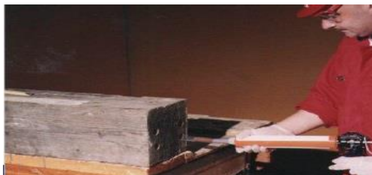
Fig.3.14.- Injecção da Cola (dir.) (Fonte: [34])
