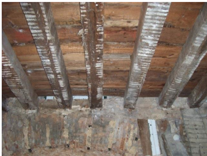
Fig.1.1- Pavimento de Madeira de um Edifício Pombalino - Vigas e soalho
