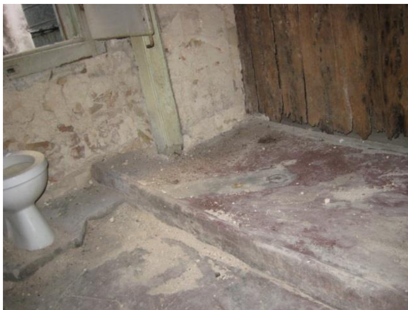
Fig.2.8.- Camada de betonilha adicionada sob o pavimento
