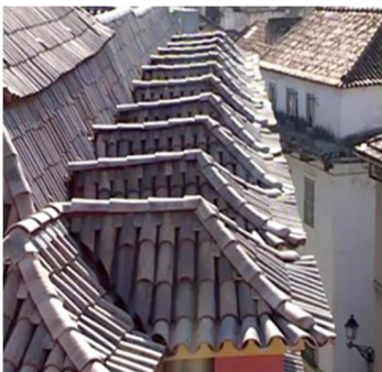
Fig. 70. Rincões ventilados . Edifício Rodrigues Lobo - Leiria fonte: DAC.DAT UM (2010)
