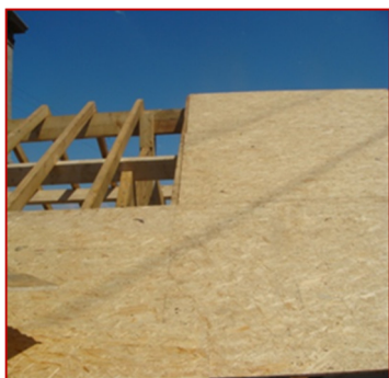
Fig.149. Forro em painéis OSB
