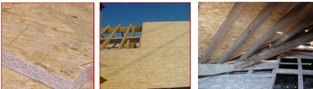
Fig 46. Exemplo de aplicação de placas de aglomerado de partículas longas e orientadas “OSB”
