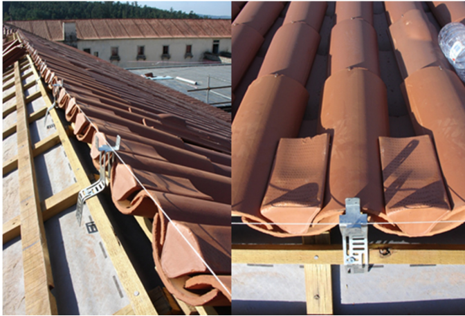
Fig. 94. Grampo de fixação da cumeeira fonte: DAC.DAT UM (2008)
