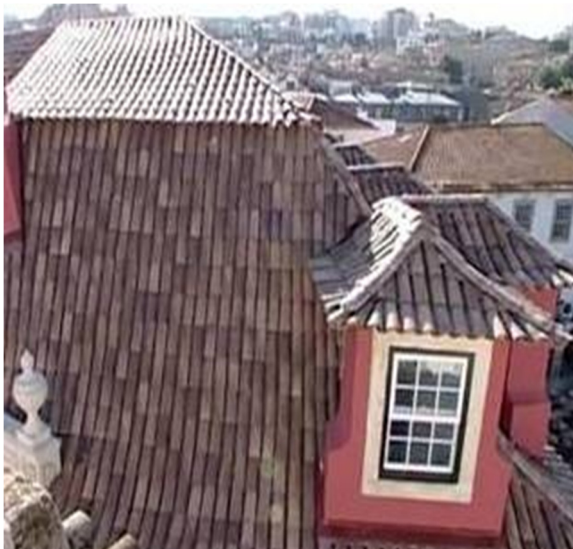
Fig 20. Exemplo de uma cobertura com pendentes superiores a debitar água sobre pendentes inferiores
