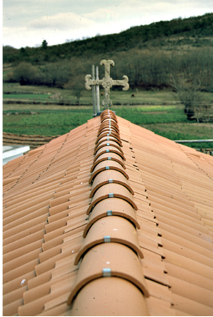
Fig. 68. Cumeeira ventilada . Igreja de S. Leocádia - Chaves fonte: DAC.DAT UM (2002)
