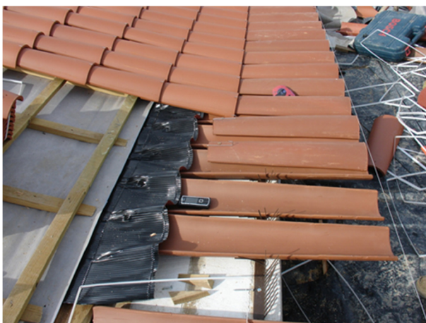
Fig. 96 Fita plissada em alumínio para ligação da membrana de alta densidade às bicas do beirado fonte: DAC.DAT UM (2008)
