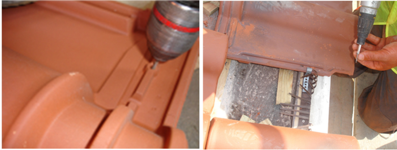
Fig. 100 Fixação dupla das peças de beiral . aparafusamento e grampo especial fonte: DAC.DAT UM (2008)
