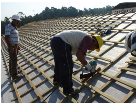
Fig.152. Ripado e contra – ripado em madeira de pinho
