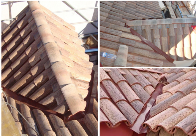
Fig. 73. Exemplos de Larós ventilados . Edifício Rodrigues Lobo - Leiria fonte: DAC.DAT UM (2010)
