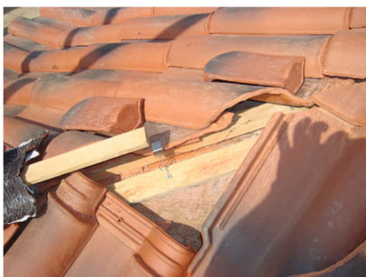
Fig. 102 Fixação de peças cortadas . grampo especial fonte: DAC.DAT UM (2008)
