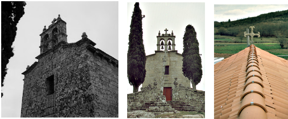
Fig. 2. Igreja de Santa Leocádia - Chaves – cobertura ventilada Fonte: UM (2004)
