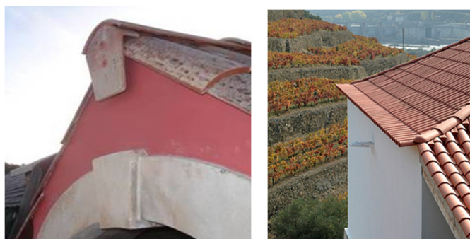
Fig. 88. Exemplos de aplicação deste tipo de remate – solução 1 fonte: DAC.DAT UM (2010)
