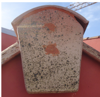
Fig. 79. Aplicação de um topo cerâmico no telhão de canudo . Edifício Rodrigues Lobo - Leiria fonte: DAC.DAT UM (2010)
