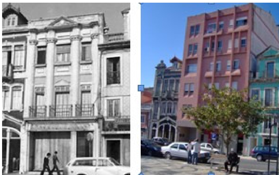
Figura 89 – Edifício Demolido (Gazeta das Caldas, 2013)
