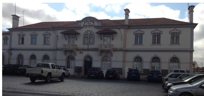
Figura 61 – Estação do Caminho de Ferro (Foto do Autor, 2013)
