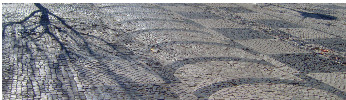
Figura 107 – Pavimento Corrigido e Inalterável (Foto do Autor, 2012)
