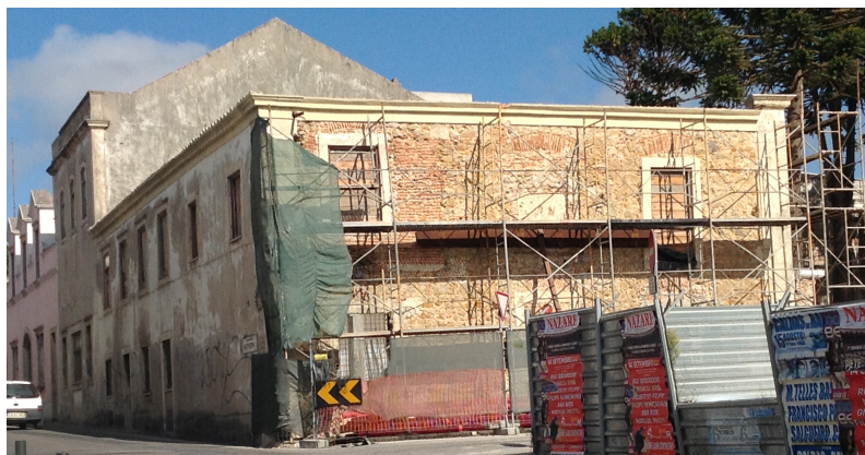
Figura 111 – Futuro Edifício Espaço Turismo (Foto do Autor, 2013)
