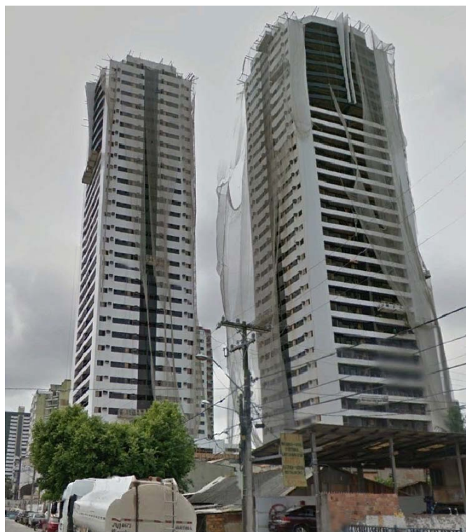
Figura 3.1 - Imagem da Torre B (edifício retratado à direita) do Condomínio Rio Mendoza, Belém do Pará (BR) [51].
