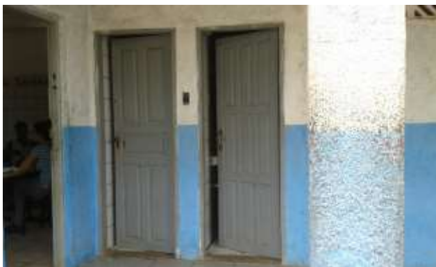
Fotografia 8 - Escola Mc Linn da Quebrada (banheiros)
