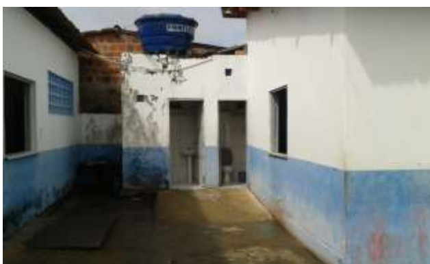
Fotografia 9 - Escola Mc Linn da Quebrada (banheiros)
