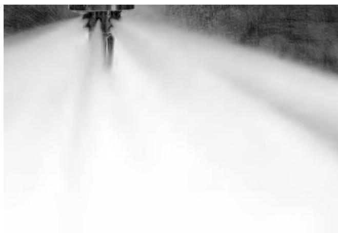
Figura 18 - Expressor de água nebulizada em funcionamento (Fonte: Catalog systems for buildings 2008, www.marioff.com )
