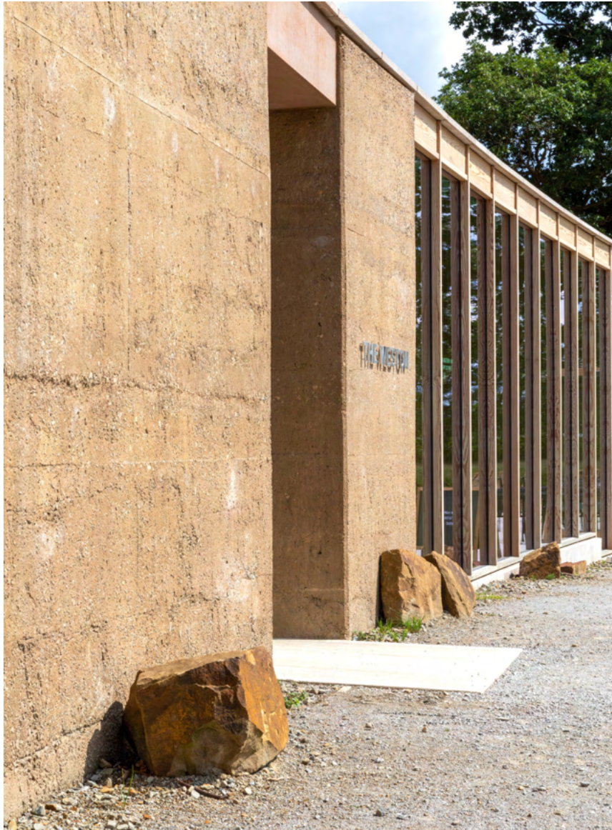
Figura 57 Fachada Oeste do Edifício “The Weston” no Parque das Esculturas Yorkshire.
