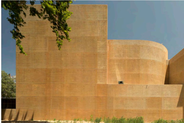
Figura 22 Materialidade fachada oeste, betão pigmentado, Teatro Thalia, Lisboa 2008 de Gonçalo Byrne e Barbas Lopes Arquitectos.
