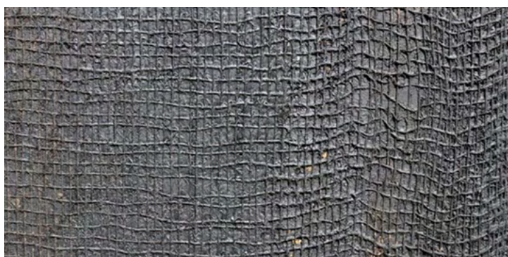
Figura 26 “Pele do edifício, materialidade de combinação de Idenden preto, com tela de juta e areia”; Transformação da cor preta numa cor tátil com consequência de um espaço háptico, “Serpentine Gallery”, Pavilhão Londres 2011 de Peter Zumthor.
