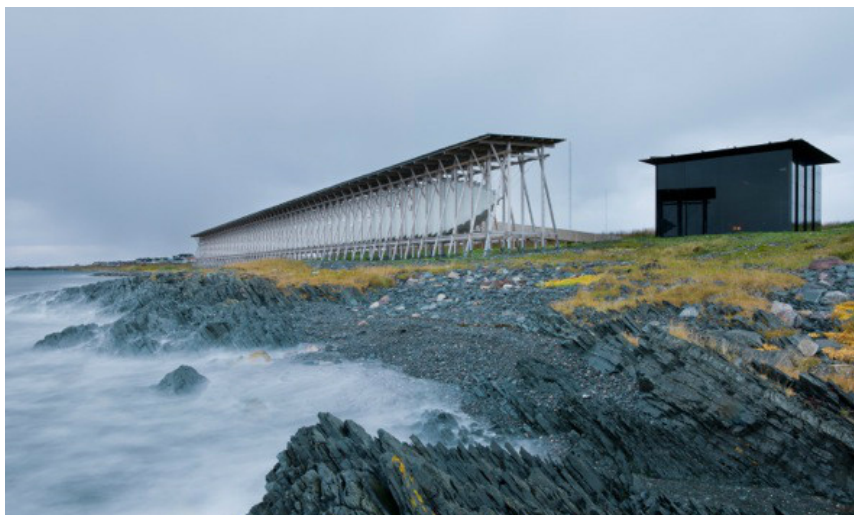
Figura 30 Estrutura da direita: “Casa da Memória” de Zumthor e estrutura da esquerda: “Casa de Vidro” de Louise, “Memorial Steilneset”, Vardø Noruega 2011 de Peter Zumthor e Louise Bourgeois.
