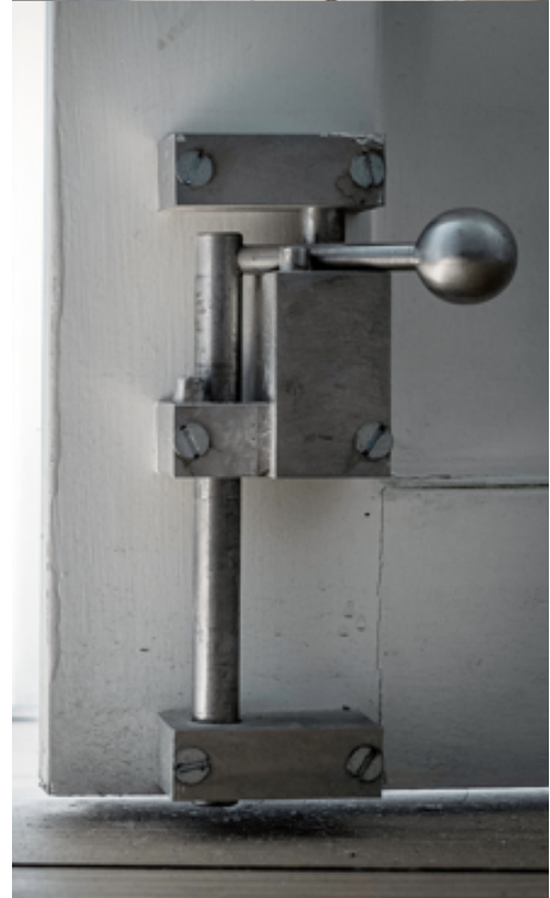
Fig. 44 – As ferragens anteriores ao incêndio, e as que foram desenhadas por Siza
