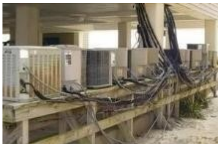
Fig. 30. Exemplos de Má Implantação dos Sistemas de AVAC
