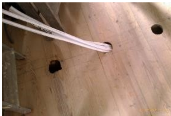
Fig. 96. Atravessamento de Tubagens no Pavimento
