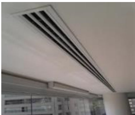
Fig. 57. Difusor Linear em Teto Falso
