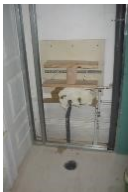
Fig. 95. Emparelhamento das Instalações Sanitárias (Esq.) e Ancoragens estruturais (Dir.)
