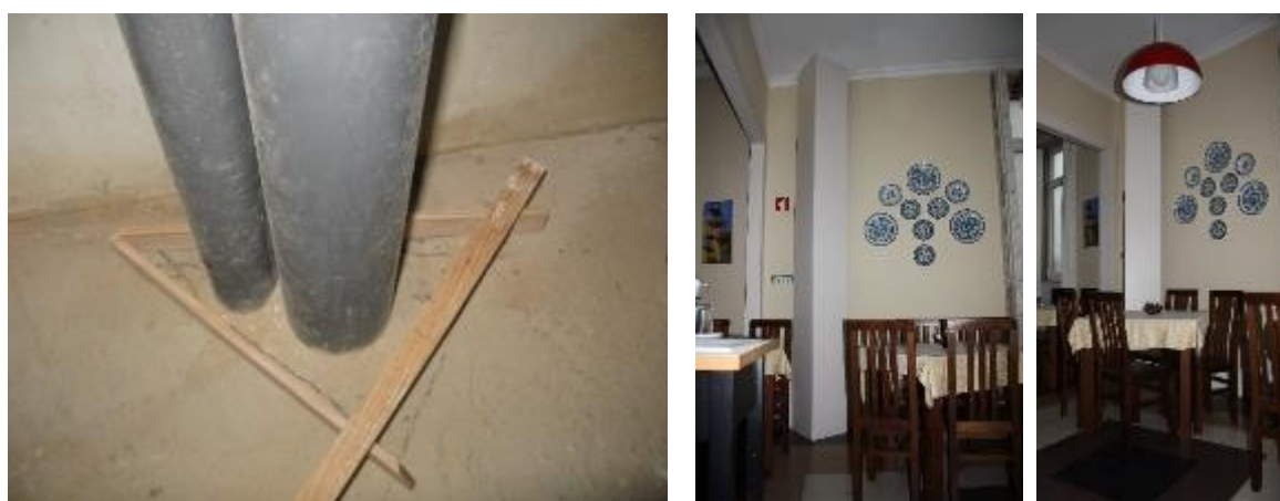
Fig. 94. Base da Courette (Fase de Construção, à Esq.) e Resultado Final na Sala de Refeições (Dir.)
