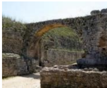
Fig. 2. Aqueduto de Conímbriga
