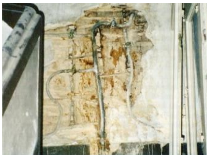
Fig. 17. Pormenor de Redes de Água em Chumbo
