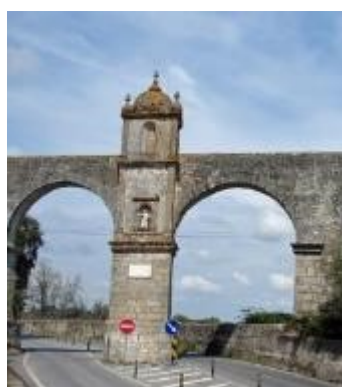
Fig. 13. Aqueduto da Água da Évora
