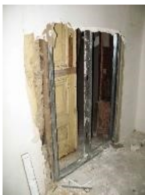
Fig. 88. Elementos em madeira não tratados ou apodrecidos, ocultos pelo sistema de gesso cartonado (2012/15)
