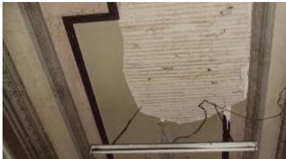
Fig. 102. Desagregação de Estuque no Corredor
