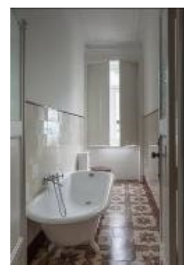
Fig. 73. Instalação Sanitária, Piso 1 (depois)
