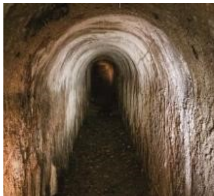
Fig. 12. Túnel de Saneamento, Convento de Mafra, Mafra
