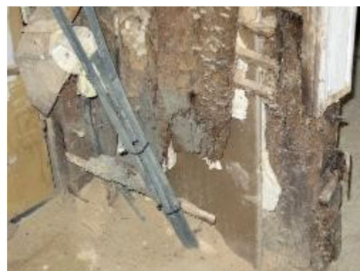
Fig. 88. Elementos em madeira não tratados ou apodrecidos, ocultos pelo sistema de gesso cartonado (2012/15)
