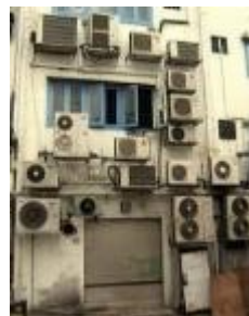
Fig. 30. Exemplos de Má Implantação dos Sistemas de AVAC
