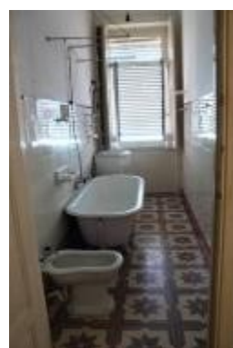
Fig. 72. Instalação Sanitária, Piso 1 (antes)
