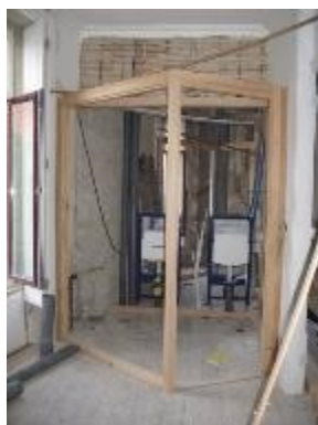
Fig. 95. Emparelhamento das Instalações Sanitárias (Esq.) e Ancoragens estruturais (Dir.)
