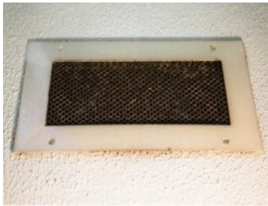
Fig. 54. Exemplo de Grelha de Ventilação
