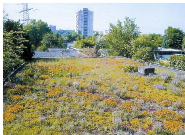
Figura 21 - Jardim de cobertura extensiva.
