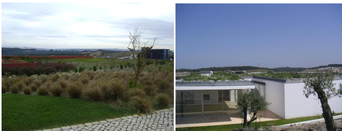
Figura 164 e 164a - Coberturas verdes extensivas
