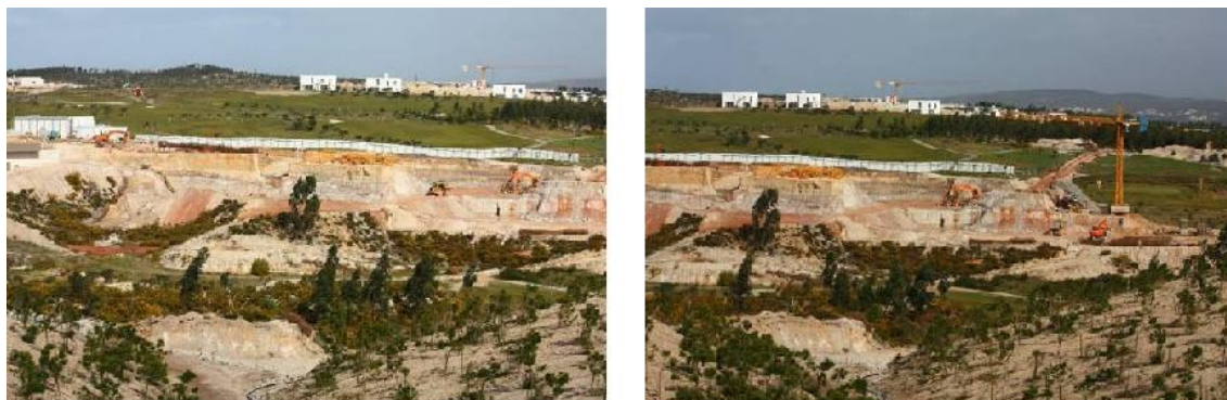
Figura 166 - Hotel Hilton em construção
