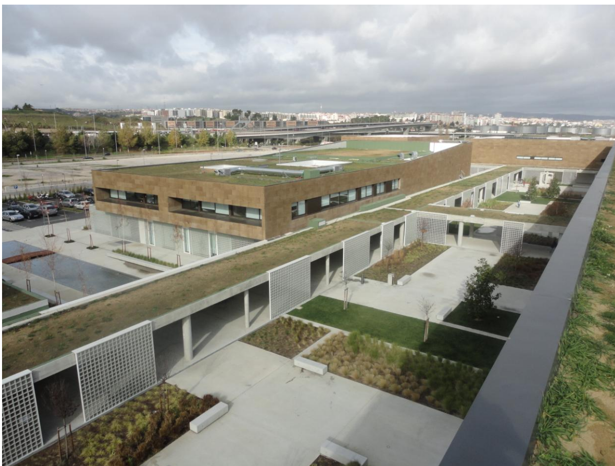
Figura 170 - Pátio/recreio ajardinado, e os corredores cobertos com coberturas planas vegetais
