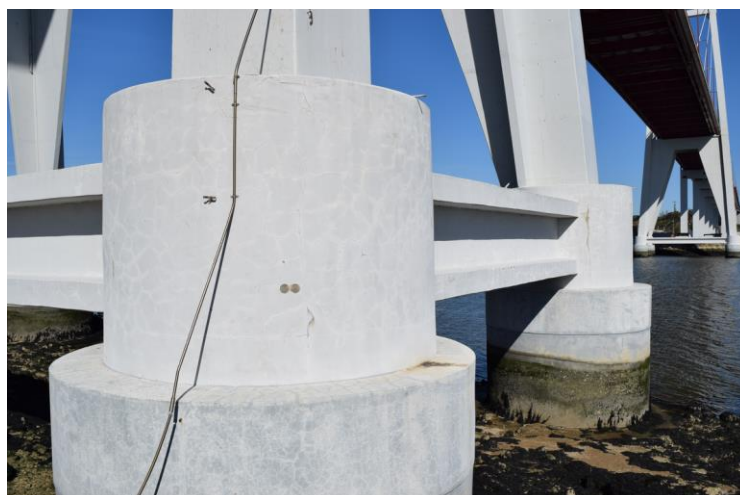
Figura 4.4 – Fundações das torres da Ponte Edgar Cardoso (Afonso, 2015).
