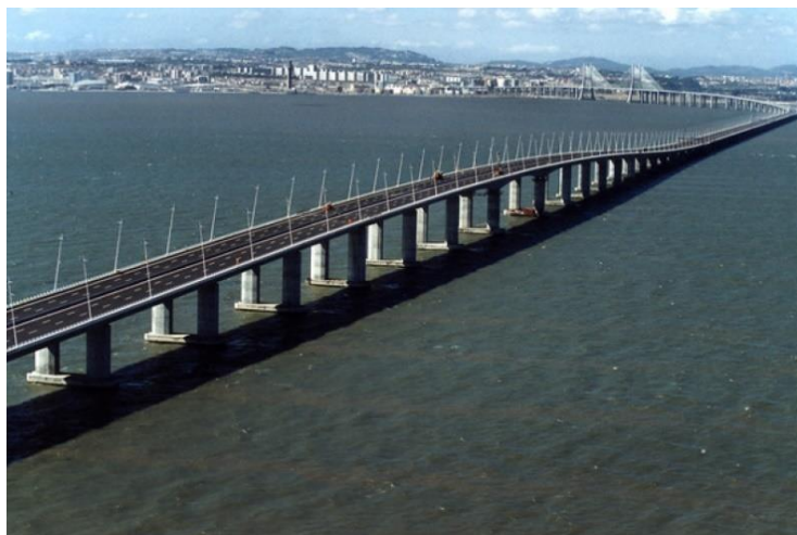
Figura 2.8– Exemplo de ponte com tabuleiro vigado: Ponte Vasco da Gama (Junceiro, 2018).
