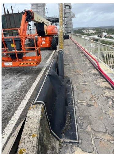
Figura 4.9 - Ancoragem das pontes protegidas por uma manga plástica.
