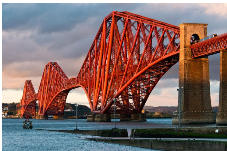
Figura 2.12 – Ponte Forth (Oglethorpe, 2023).
