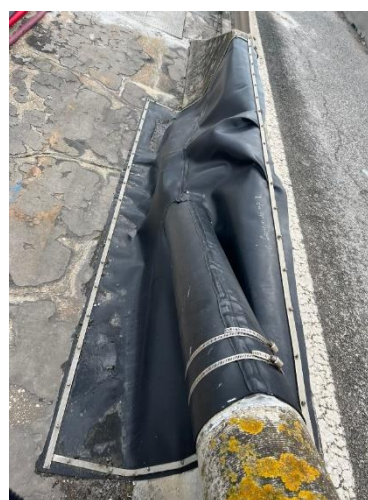
Figura 4.9 - Ancoragem das pontes protegidas por uma manga plástica.
