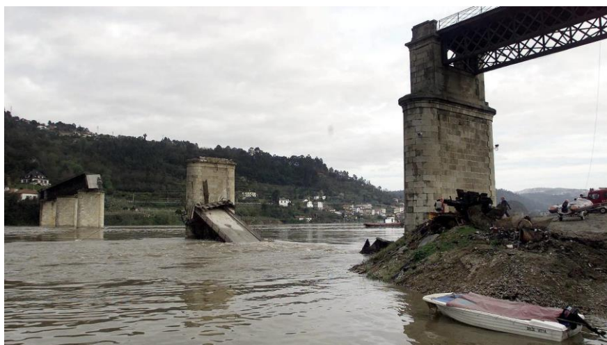
Figura 3.2. Colapso da ponte Hintze Ribeiro em 2001 (Agência Lusa, 2021).
