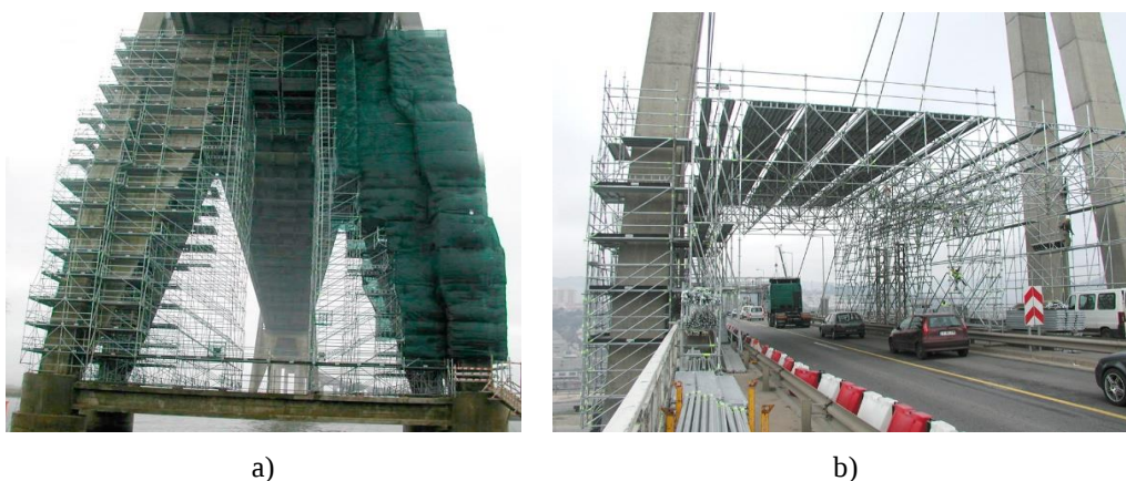
Figura 4.6 – Reabilitação da ponte até 2006 (Ulma, 2018).
