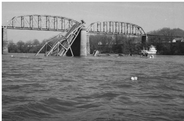
Figura 3.1. Colapso da ponte Silver Bridge em 1967 (thestructuralengineer.info, 2015).
