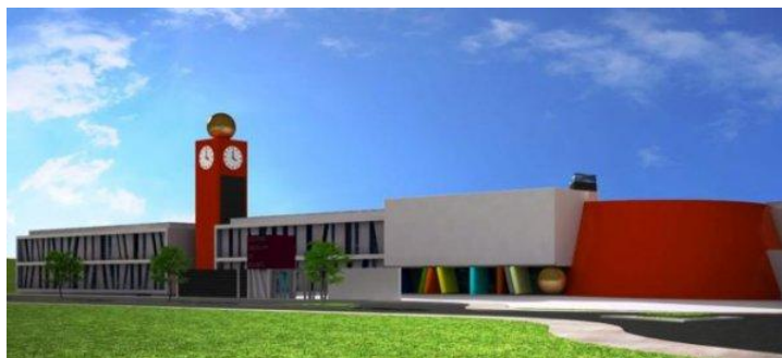
Figura 9 - Centro Escolar de Sousel
