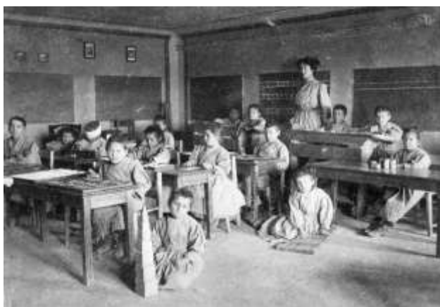
Figura 3-Sala de aula, Casa dei Bambini. Fonte: Villa di Maria, Montessori school.
