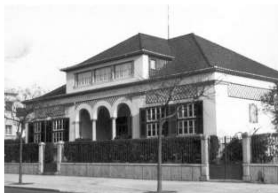
Figura 42-Fachada Jardim-Escola João de Deus na Estrela, 1945. Fonte da imagem: FP16.17 (MJD)
