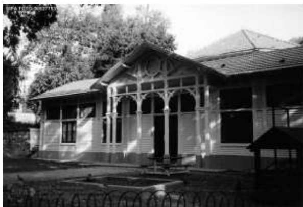
Figura 1-Fotografia da fachada principal. Fonte: SIPA FOTO.00537753
