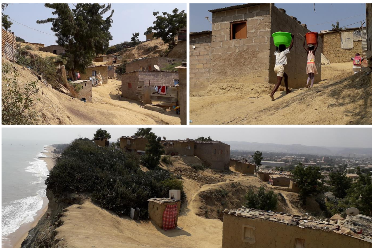
Figura 15 | Construções precárias em área de risco, bairro Inconcon, 2019. Fonte: (Autor)
