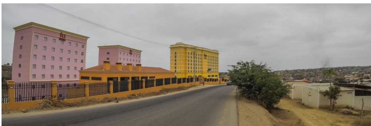
Figura 29 | Novos edifícios construídos junto a AN100, 2018. Fonte: (Matheus Hobold Sovereign)
