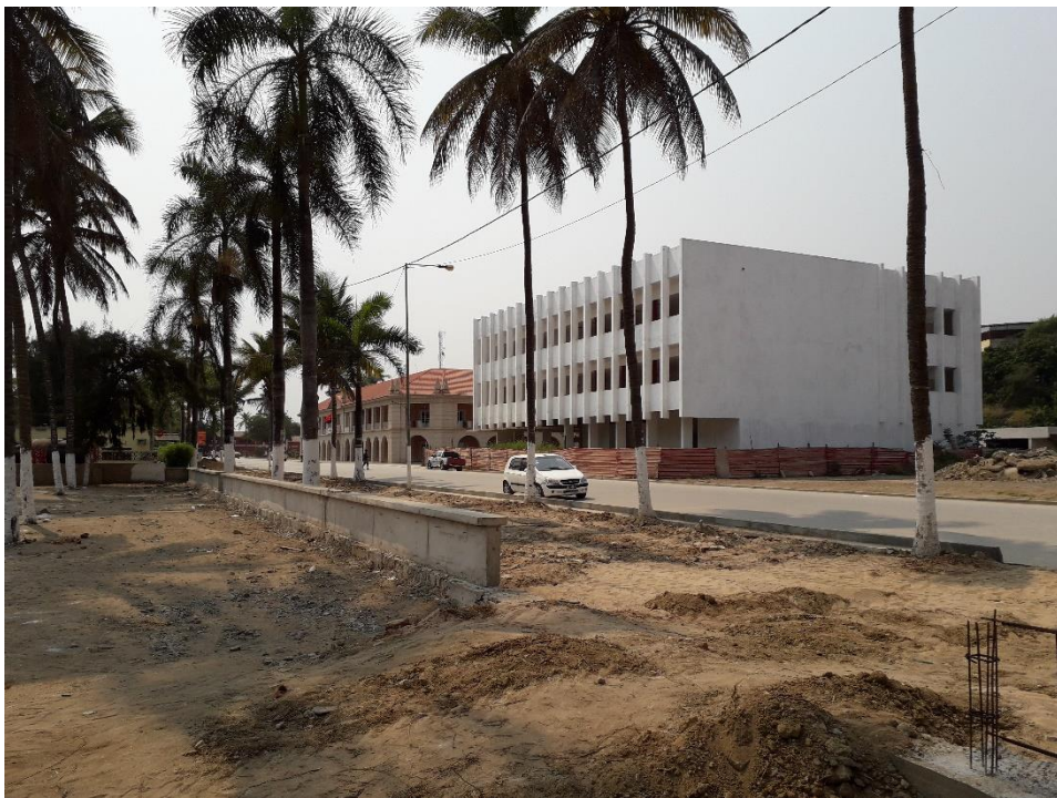
Apêndice VIII | Obras de reconstrução dos passeio na Avenida marginal. Núcleo colonial
