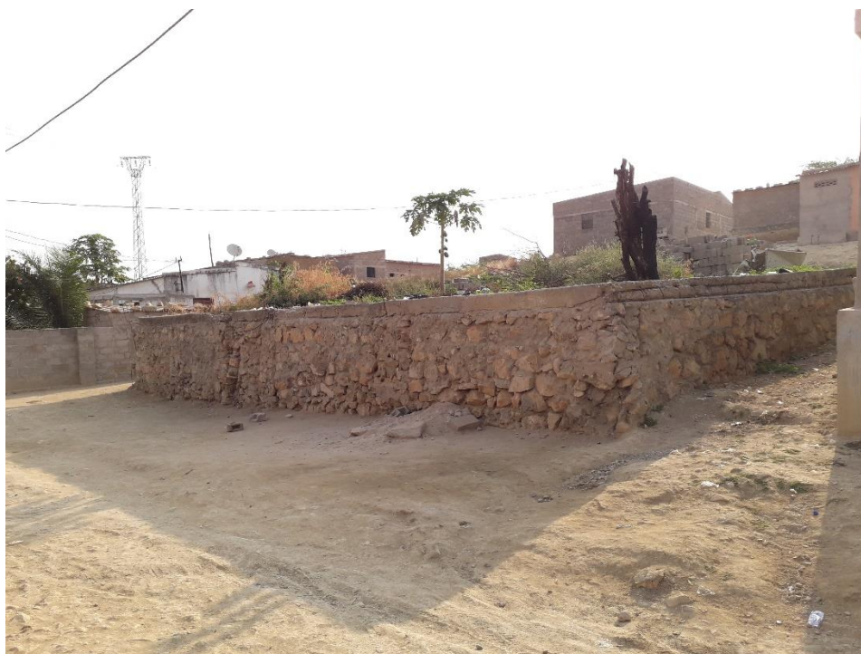
Apêndice XXIII | Embasamento para nivelamento do terreno. Musseque labiríntico.
