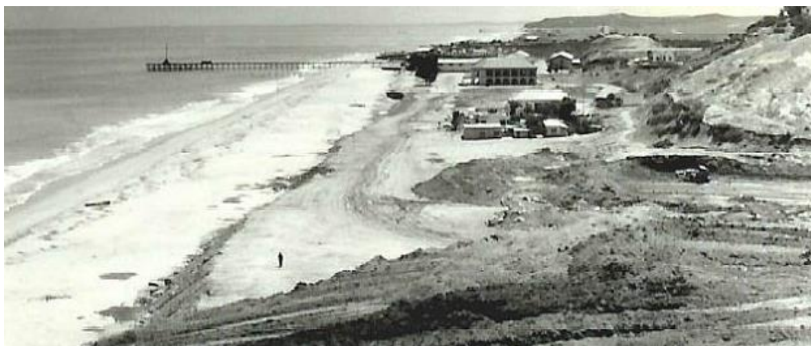
Figura 9 | Terraplanagem para construção da Igreja e a casa do Governador ,1960. Fonte:( http://motorsportinangola.blogspot.com )
