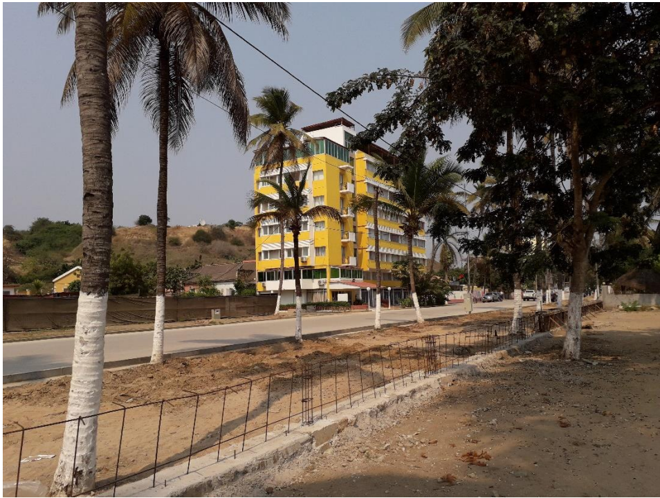
Apêndice VII | Obras de reconstrução dos passeio na Avenida marginal. Núcleo colonial
