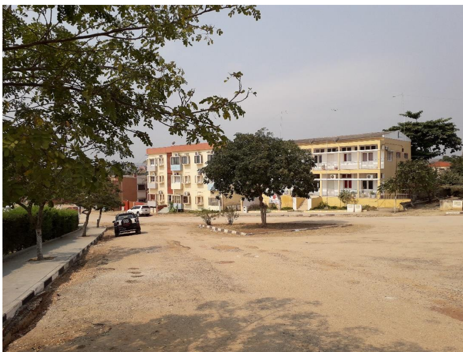
Apêndice II | Rua localizada no núcleo colonial
