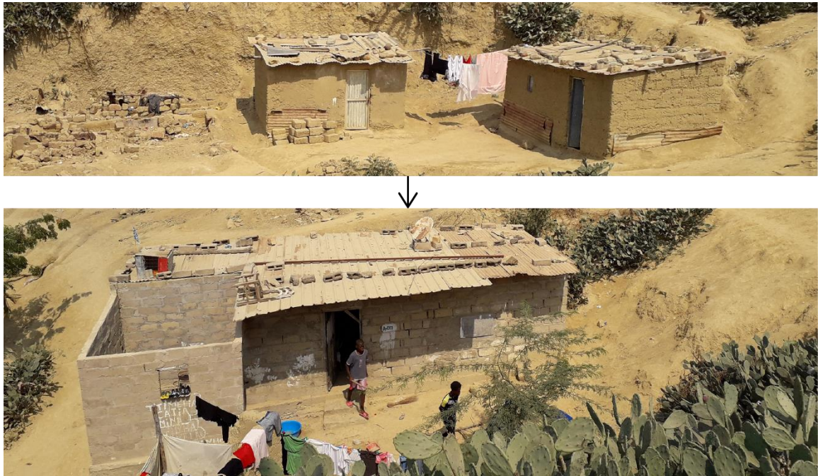
Figura 41 | Montagem, que ilustra a evolução construtiva dos edifícios nos Musseques labirínticos presentes no topo das cordilheiras a volta da cidade. Fonte: (Autor)
