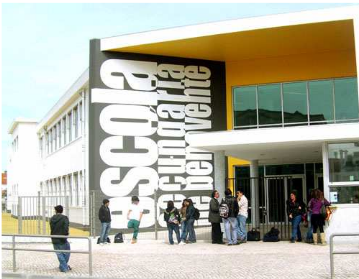
Entrada principal da Escola Secundária de Benavente
