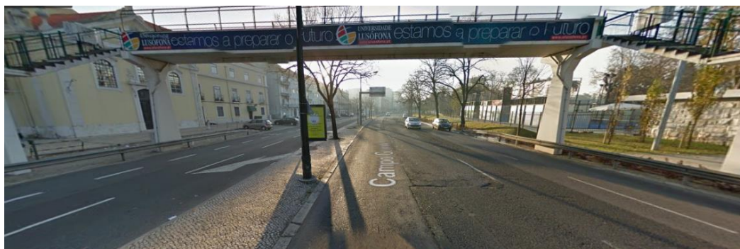
Figura 4.2 - Passagem Superior Pedonal do Campo Grande (Google, s.d.)
