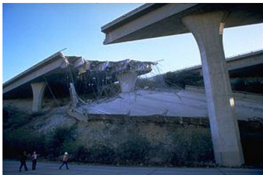
Figura 3.6 - Queda do tabuleiro vista de baixo (Delgado P. D., 2009)
