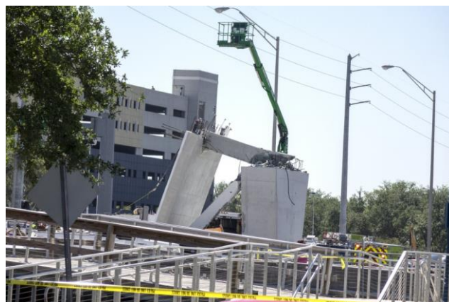
Figura 3.36 - Pilar que sofreu alterações em fase de projeto e que levou à rotura da ligação pilar-tabuleiro (Queda de ponte pedonal em Miami, 2018)
