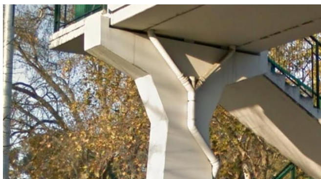
Figura 4.8 - Ligação viga-pilar simplesmente apoiada
