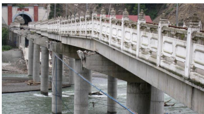
Figura 3.15 - Danos nos encontros entre tabuleiros, danos nos apoios e deslocamentos dos mesmos (Costa, Ferreira, & Oliveira, 2010)
