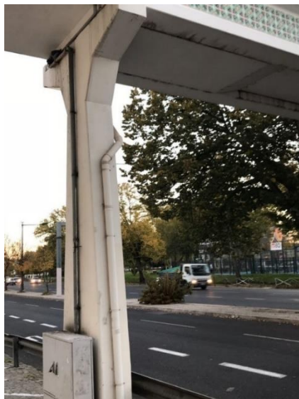
Figura 4.17 - Pilar da passagem superior pedonal
