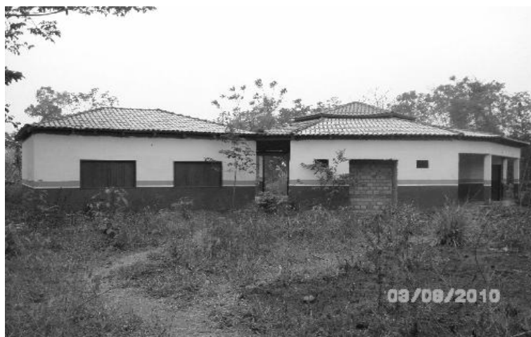
Figura 9 – Prédio novo e abandonado da Escola. Fonte: Ray
