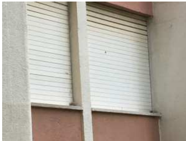
Figura 18 - Peitoril fino com aba larga para o exterior (Autor, 2017)
