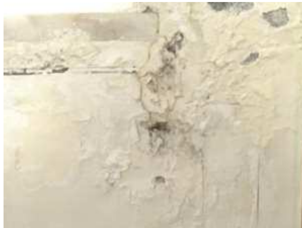
Figura 15 - Parede exterior (Autor, 2017)
