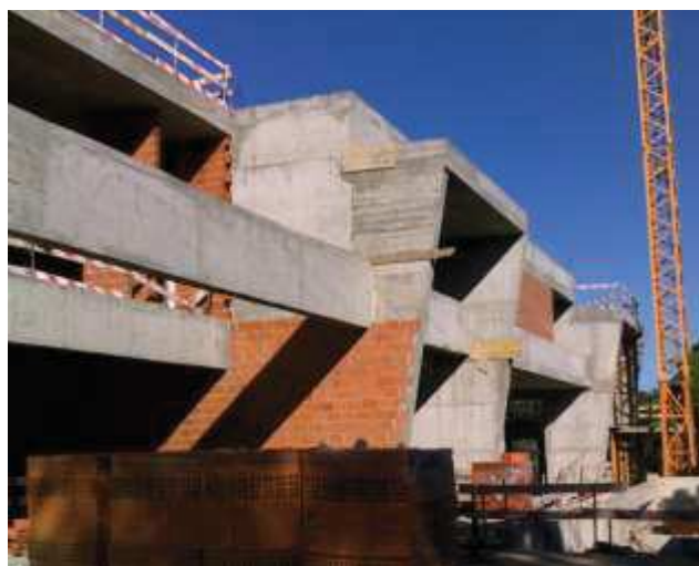
Figura 34 - Vista das paredes Par.5 e Par.M' com a viga V5.1
