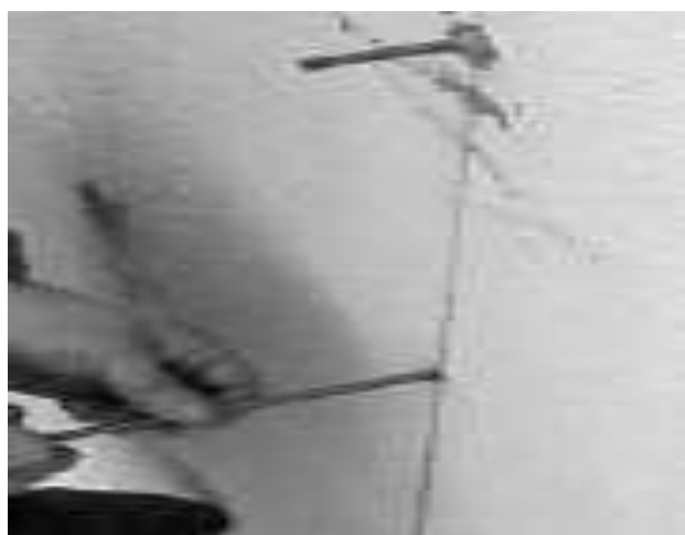
Figura 11 - Colocação do grampo em Inox (Autor, 2017)
