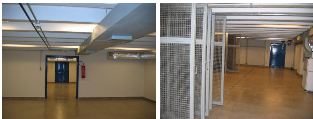
Figuras 130 e 131 - MNBA: Reserva Técnica. Vigas em estrutura metálica, equipamentos de climatização e combate de incêndio. Novos traineis em alumínio.
