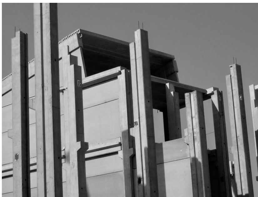
16 Construção com elementos pré-fabricados standard
