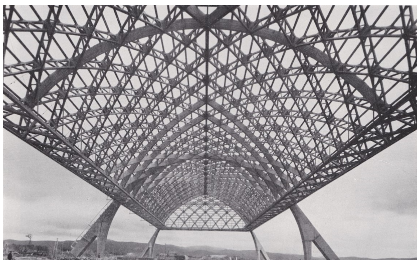
10 Estrutura pré-fabricada da cobertura do hangar
