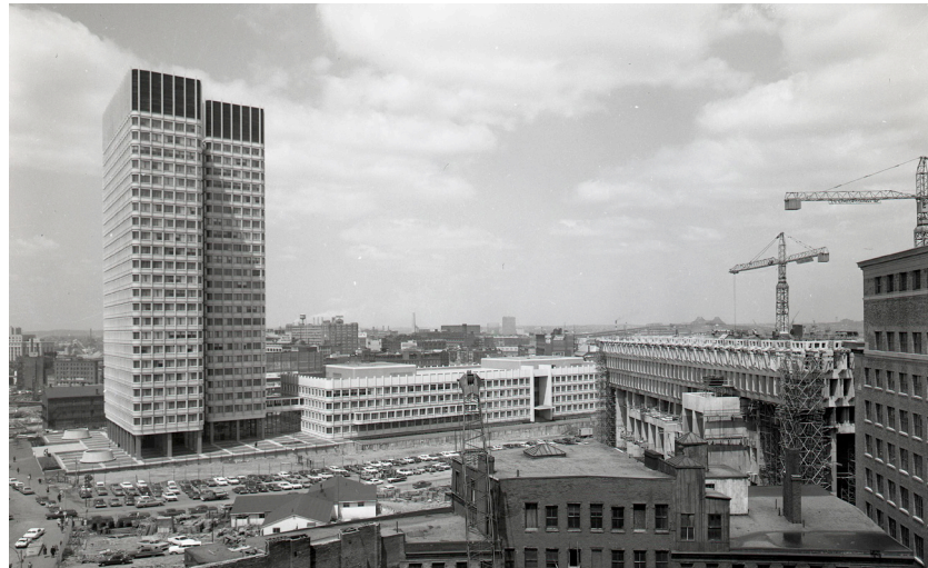
6 Vista geral sobre o edifício
