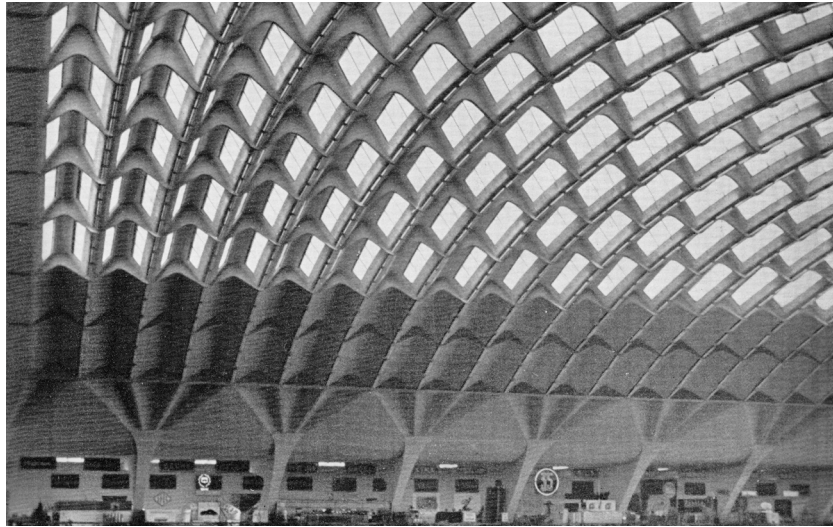
16 Cobertura do pavilhão de exposição de Turim
