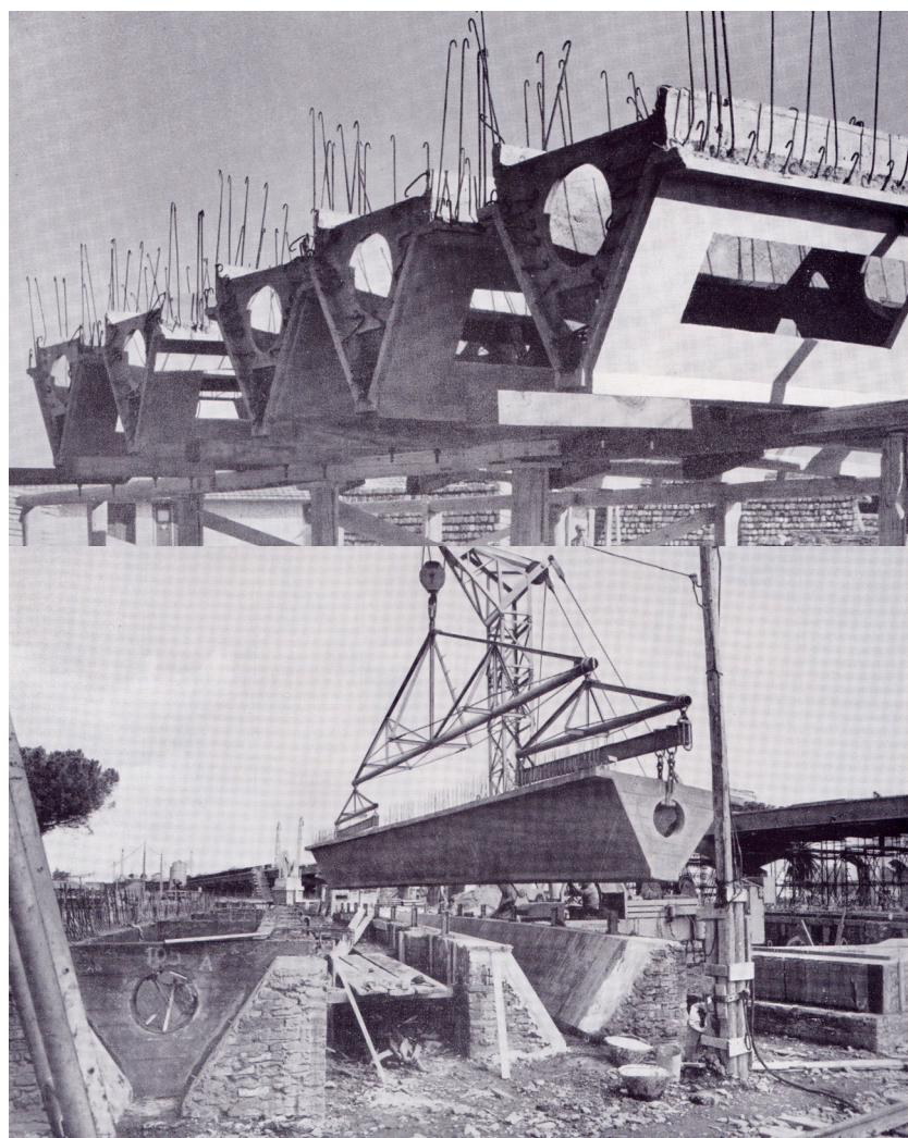
18 Processo de fabricação de elemento pré-fabricado customizado do Palácio do Desporto em Roma do Arq. Pier Luigi Nervi
