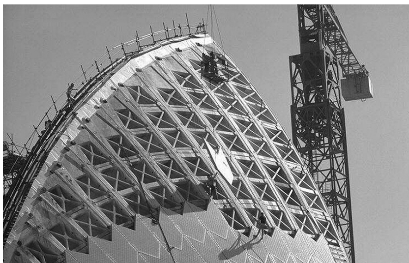
19 Construção da cobertura em elementos pré-fabricados da Casa da Ópera de Sydney
