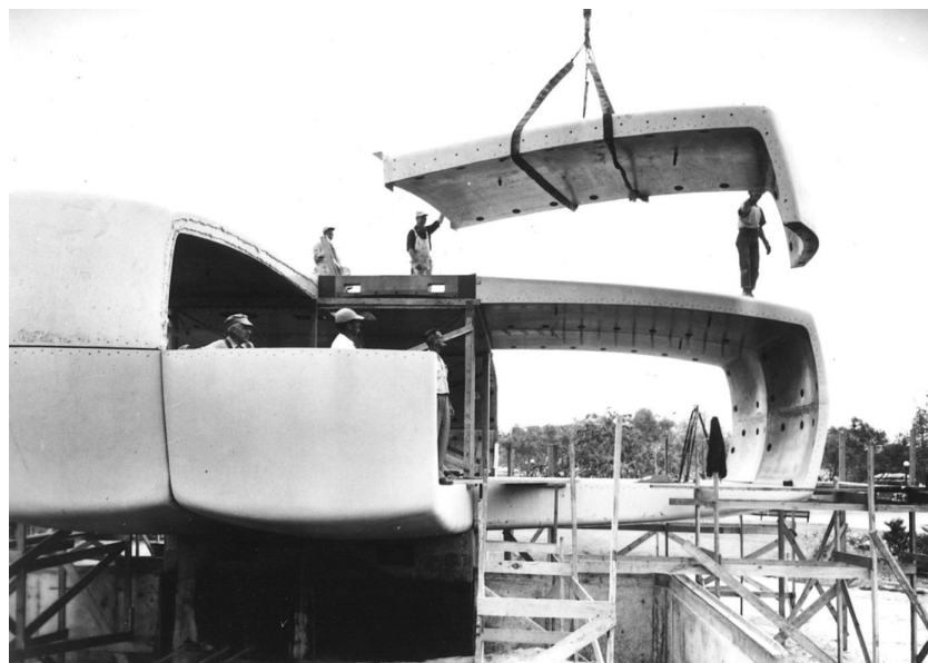
12 Construção da Casa Monsanto - Casa do Futuro com elementos pré-fabricados customizados de betão
