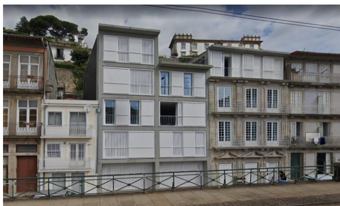
Figura 81 – Localização do lugar da intervenção, Miragaia, Porto Figura 82 – Fachada poente do edifício em ruínas, Miragaia, Porto Figura 83 – Edifício Miragaia, 2017, Rua de Miragaia, Porto
