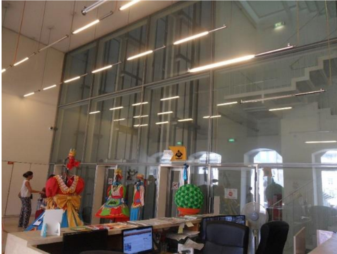
Fig.6- Átrio do elevador do Castelo no prédio da Rua dos Fanqueiros. Foto: Filipe Freitas
