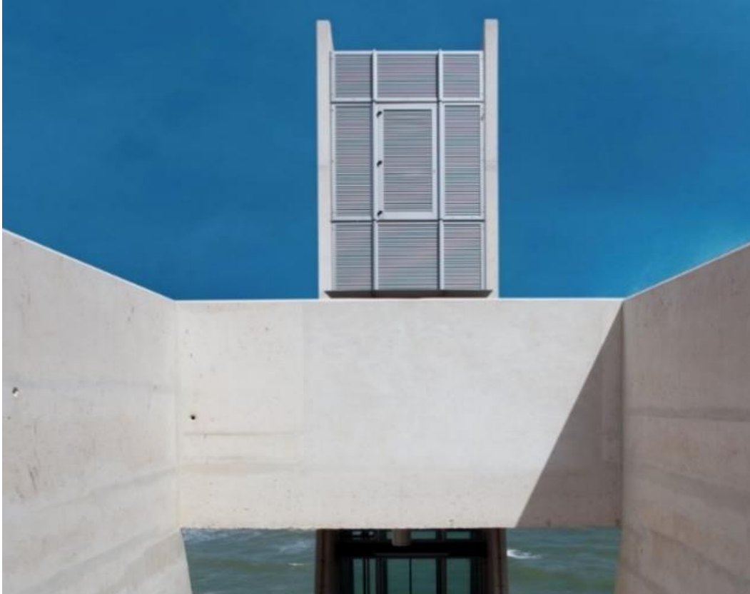
Fig.21- Estrutura do elevador do Peneco. Foto: João Pimentel Ferreira
