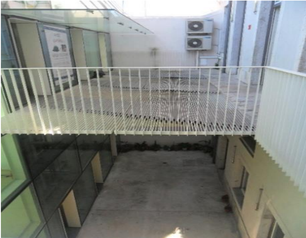
Fig.7-Vista do patamar de chegada piso de superior, vai ter à Rua da Madalena. Foto: Filipe Freitas
