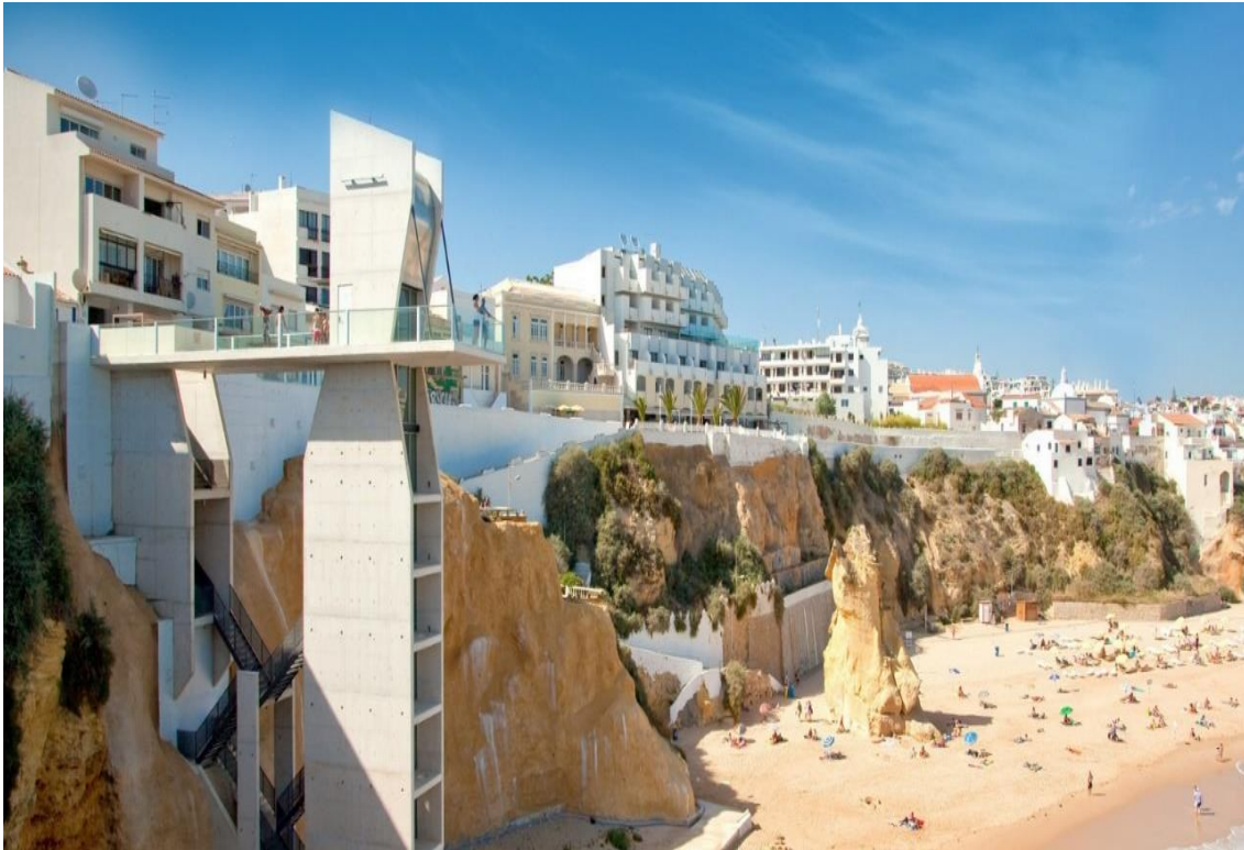
Fig.18- Enquadramento estético do elevador do Peneco na sua envolvente. Foto: João Pimentel Ferreira
