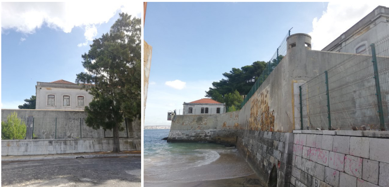
Parte do Forte de Nossa Senhora da Saúde da Trafaria.
