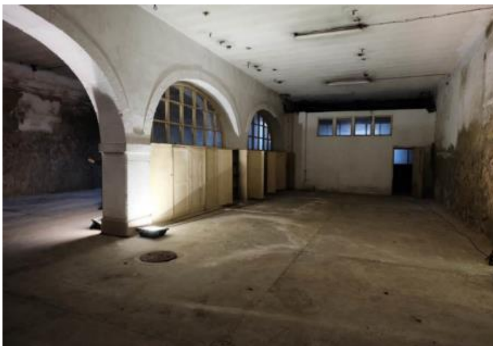
Figura 19 - No interior a arcaria de pedra no piso térreo dos armazéns. Fonte:
