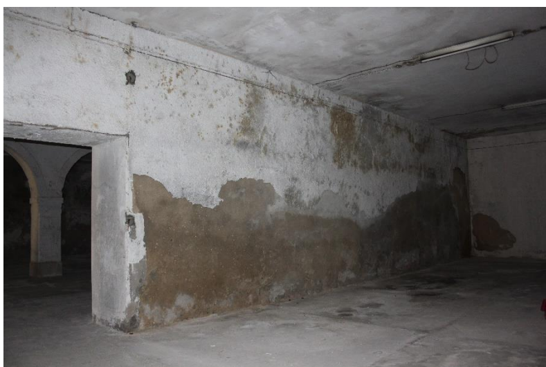
Figura 56 - Paredes interiores do piso térreo, fonte: Autor
