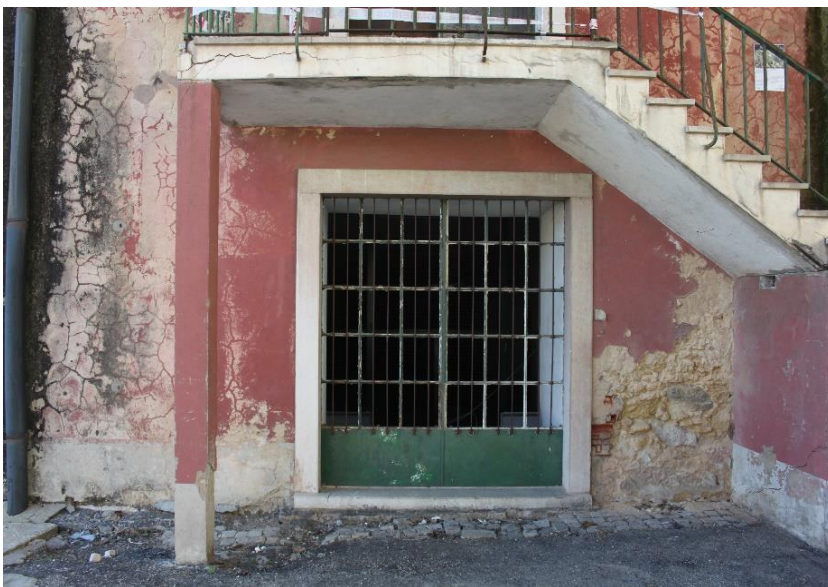
Figura 66 - Cantarias na fachada sul da rua interior da Manutenção Militar, fonte: Autor
