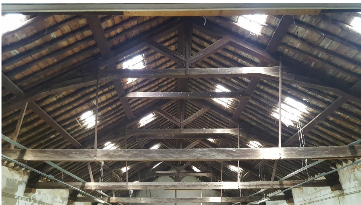
Figura 17 - Estrutura de Madeira (fotografia do autor)
