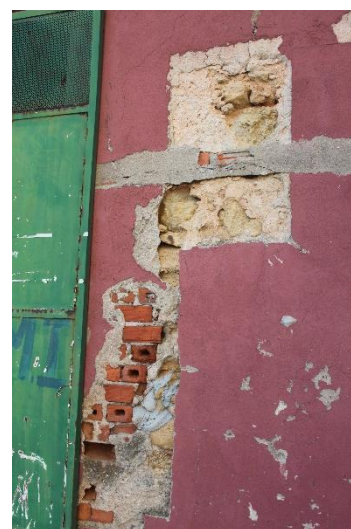
Figura 57 - Paredes exteriores, fonte: Autor
