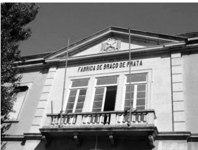
Figura 47 - Edifício 3 - Fábrica de Braço de Prata. fonte: http://restosdecoleccion.blogspot.pt
