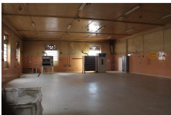
Figura 60 - Teto da nave mais a nascente, fonte: Autor
