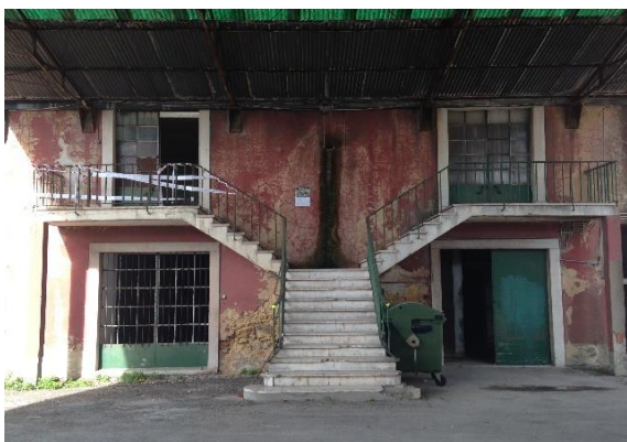
Figura 62 - Escadas existente na fachada sul da rua da Manutenção Militar, fonte: Autor
