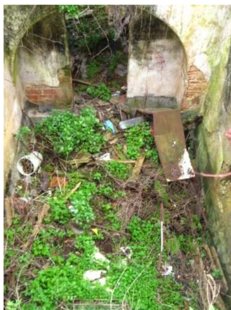
Figura 045 – Fotografia do antigo lagar. (Fonte: Foto do autor tirada no dia 2 de Fevereiro de 2011)
