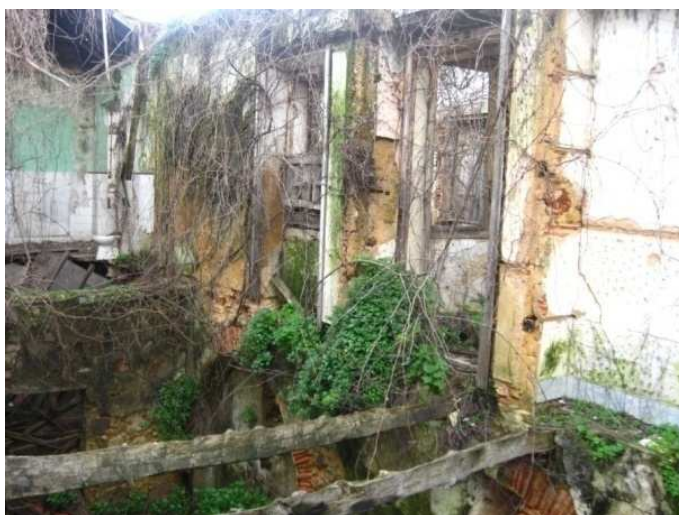
Figura 112 – Estrutura de pavimentos existente no primeiro piso na ala a poente. (Fonte: Foto do autor tirada no dia 1 de Fevereiro de 2011)
