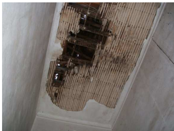
Figura 132 e 133 – Exemplo de desagregação das argamassas em tectos.
