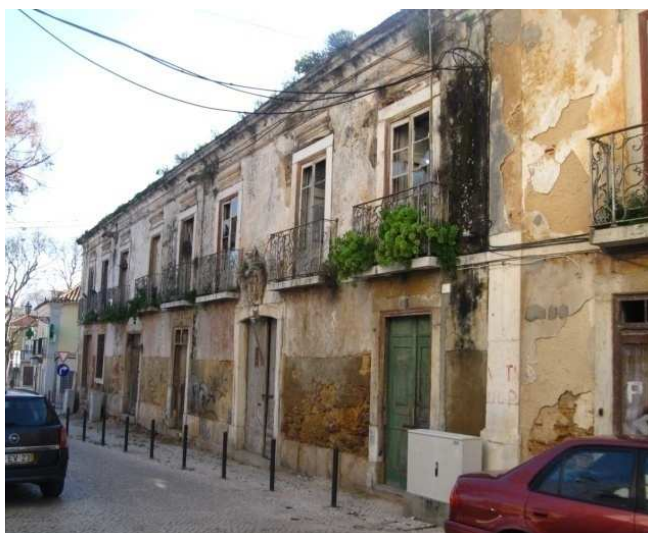
Figura 030 – Fotografia da Fachada Principal. (Fonte: Foto do autor tirada no dia 2 de Fevereiro de 2011)
