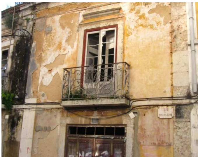
Figura 078 – Fotografia de uma varanda da fachada principal. (Fonte: Foto do autor tirada no dia 2 de Fevereiro de 2011)
