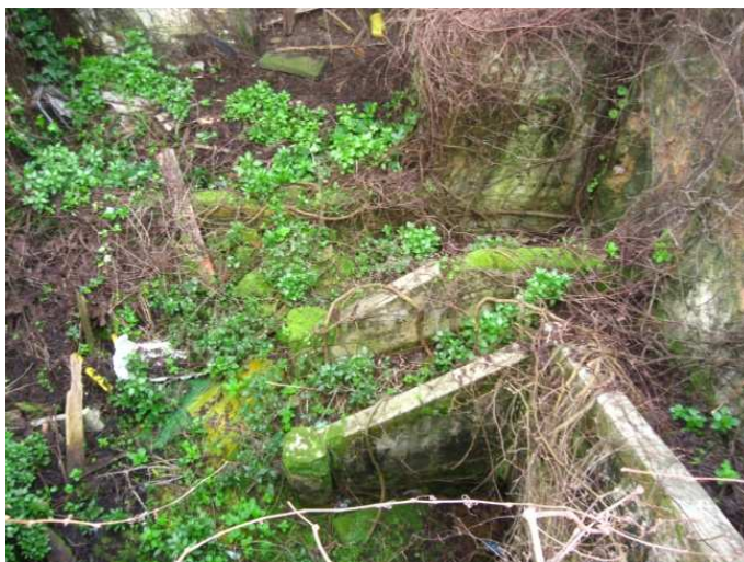
Figura 041 – Fotografia do pátio existente na ala norte do edifício. (Fonte: Foto do autor tirada no dia 2 de Fevereiro de 2011)
