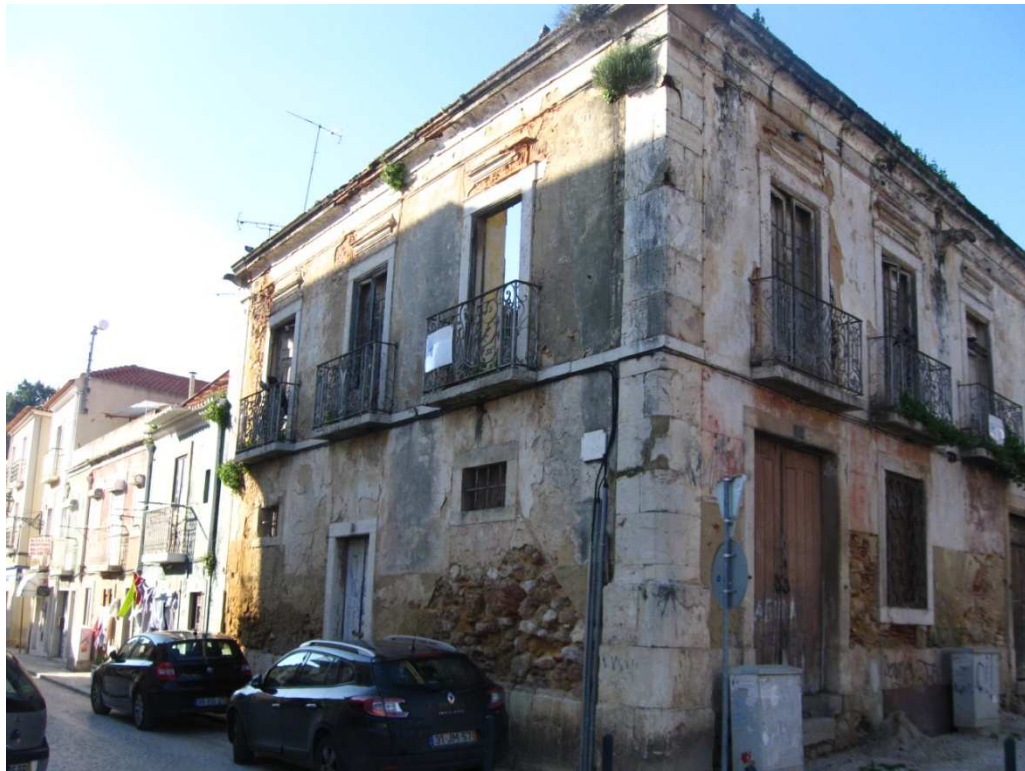
Figura 035 – Fotografia da Fachada a Sul vista da Rua Paulino de Oliveira. (Fonte: Foto do autor tirada no dia 2 de Fevereiro de 2011)
