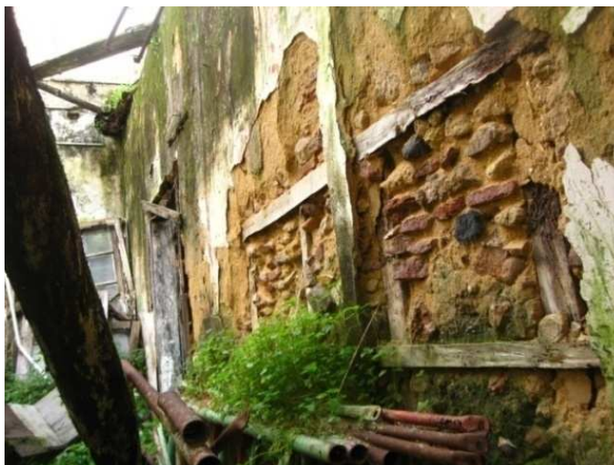
Figura 072 – Fotografia da parede na área de loja de latoaria. (Fonte: Foto do autor tirada no dia 2 de Fevereiro de 2011)
