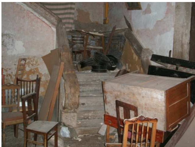
Figura 074 – Fotografia da escadaria principal do edifício. (Fonte: Fotografia fornecida pelo actual proprietário, Eng.º Pedro Novais.)
