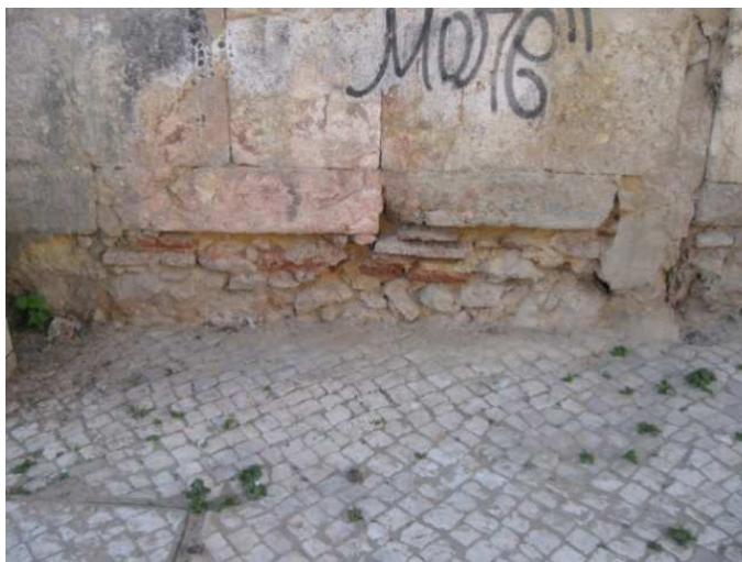
Figura 070 – Fotografia das fundações visíveis. (Fonte: Foto do autor tirada no dia 26 de Janeiro de 2011)
