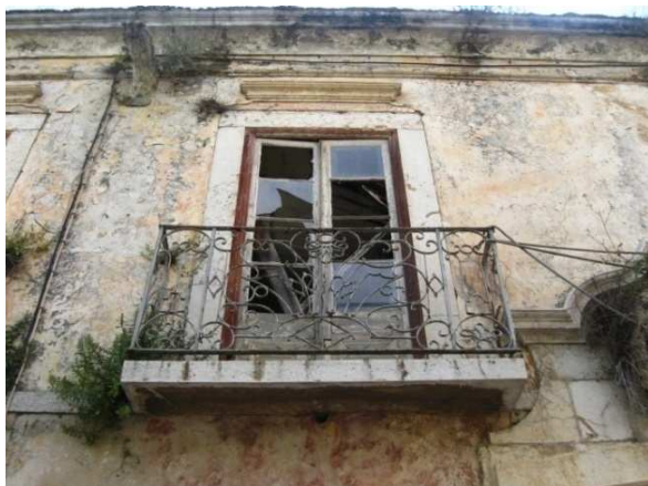
Figura 027 – Janela de sacada e resguardo de ferro da fachada principal. (Fonte: Foto do autor tirada no dia 2 de Fevereiro de 2011)
