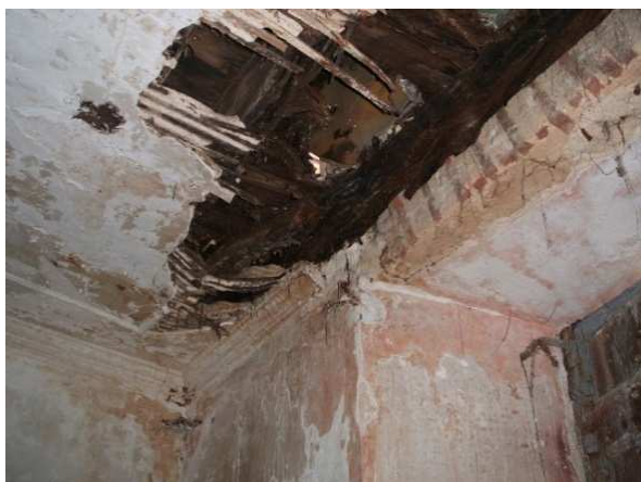
Figura 132 e 133 – Exemplo de desagregação das argamassas em tectos.
