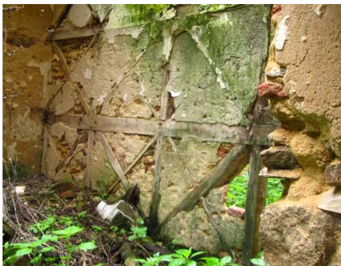
Figura 071 – Fotografia da parede existente no armazém (Fonte: Foto do autor tirada no dia 26 de Janeiro de 2011)
