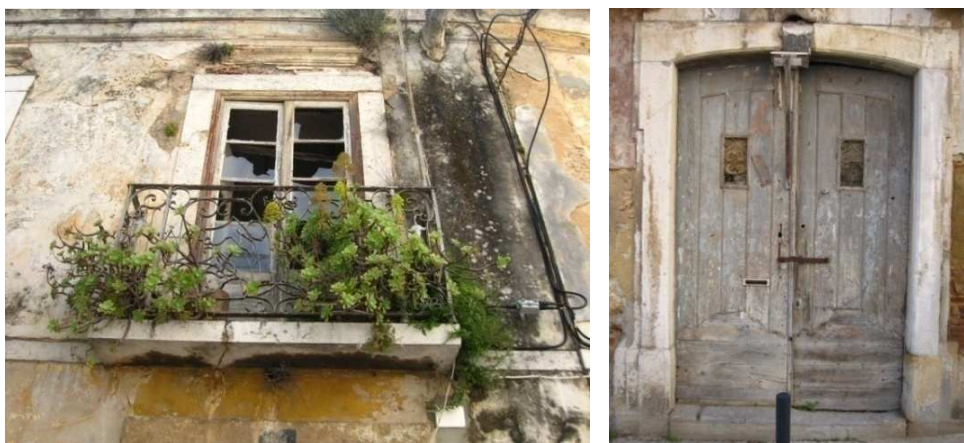
Figura 124 e 125 - Fotografia de uma janela existente na fachada principal e Porta principal. (Fonte: Foto do autor tirada no dia 28 de Abril de 2011)
