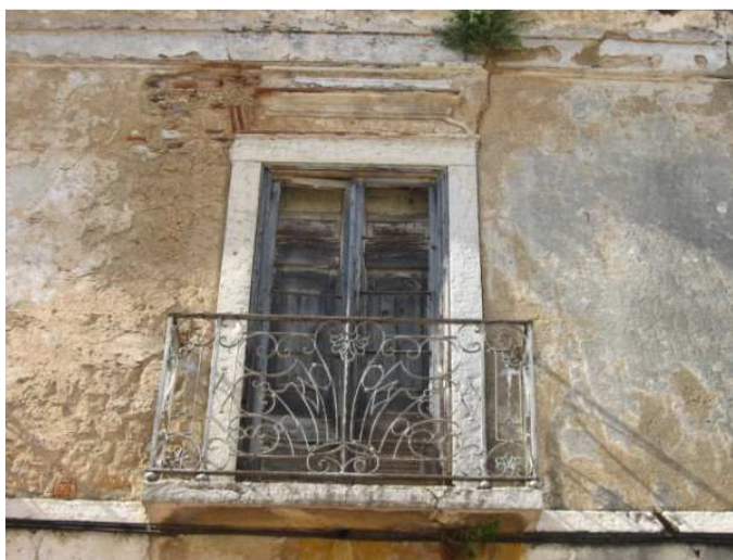
Figura 090 – Fotografia de uma janela de sacada da fachada principal. (Fonte: Foto do autor tirada no dia 2 de Fevereiro de 2011)
