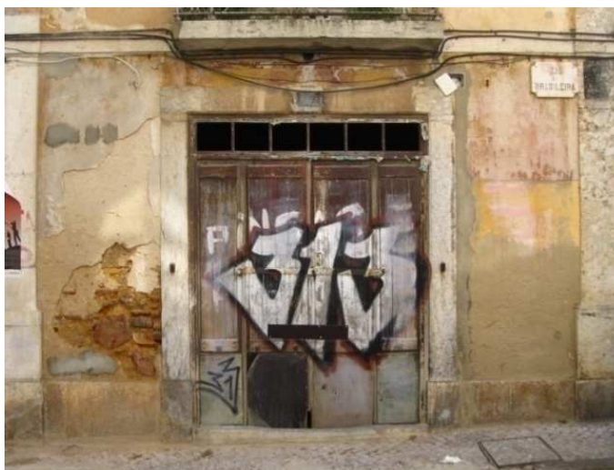
Figura 127 – Porta existente na fachada principal. (Fonte: Foto do autor tirada no dia 28 de Abril de 2011)
