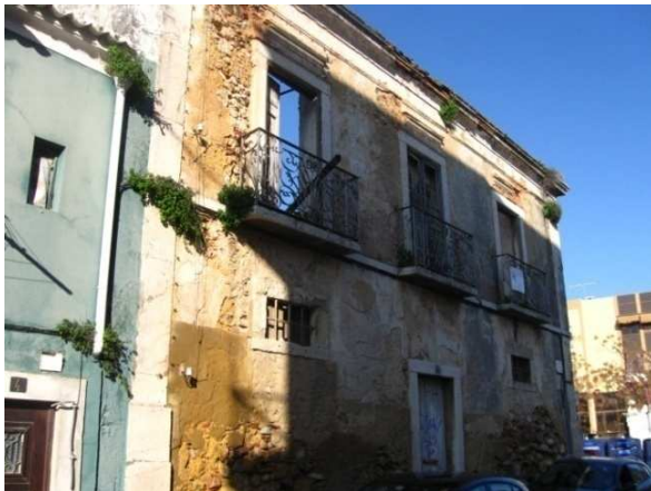
Figura 033 – Fotografia da Fachada a Sul. (Fonte: Foto do autor tirada no dia 2 de Fevereiro de 2011)
