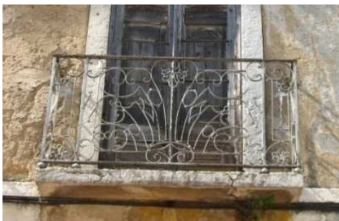
Figura 123 – Fotografia de uma varanda existente na fachada a sul. (Fonte: Foto do autor tirada no dia 2 de Fevereiro de 2011)
