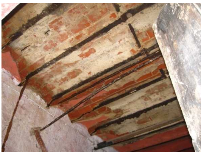
Figura 114 – Estrutura do pavimento com elementos de ferro existente na ala ponte do edifício. (Fonte: Foto do autor tirada no dia 1 de Fevereiro de 2011)
