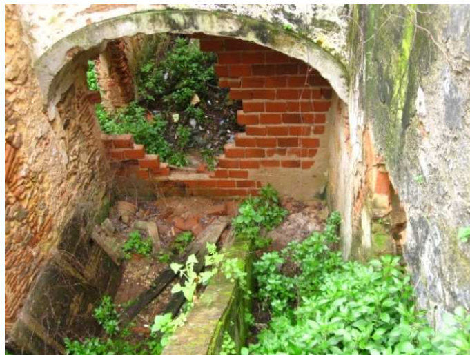
Figura 051 – Fotografia do arco existente no pátio Principal. (Fonte: Foto do autor tirada no dia 2 de Fevereiro de 2011)
