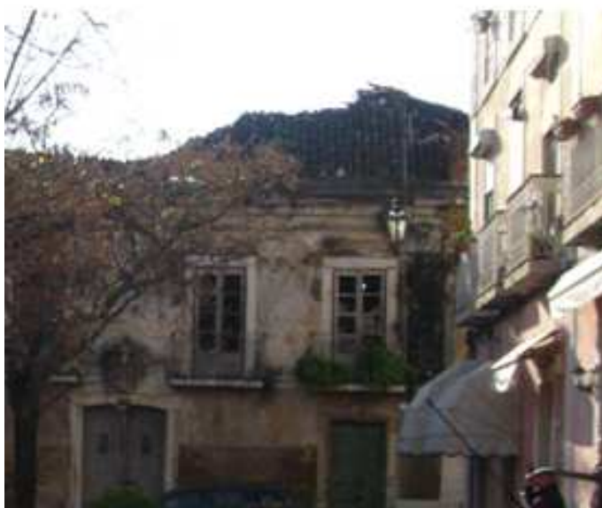
Figura 134 – Revestimento de cobertura existente.
