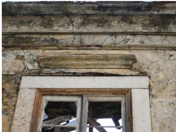
Figura 101 – Moldura superior em estuque sobre a janela de sacada na fachada a nascente. (Fonte: Foto do autor tirada no dia 2 de Fevereiro de 2011)
