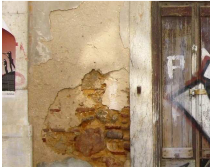
Figura 130 – Exemplo de desagregação das argamassas, na fachada principal. (Fonte: Foto do autor tirada no dia 28 de Abril de 2011)
