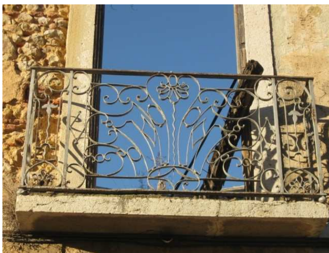
Figura 126 – Guarda de ferro de uma varanda existente na fachada sul. (Fonte: Foto do autor tirada no dia 2 de Fevereiro de 2012)
