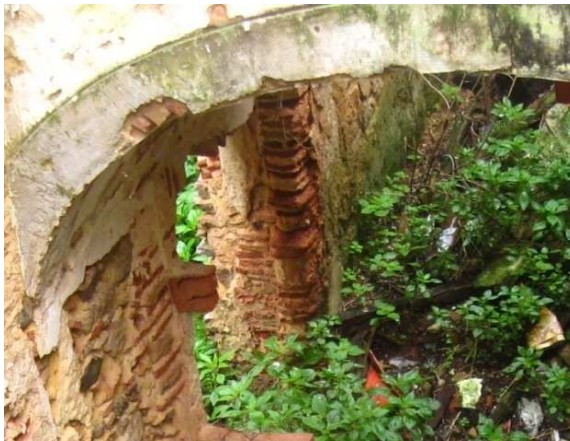
Figura 106 – Revestimento de estuque sobre reboco.
