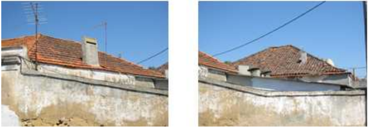
Figura 014 – Exemplo de cobertura existente (Fonte: SILVA, 2002. )
