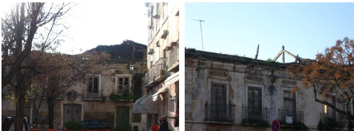
Figura 117 e 118 – Fotografias da cobertura existente no edifício. (Fonte: Foto do autor tirada no dia 28 de Abril de 2011)
