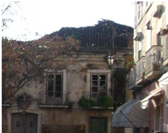
Figura 108 – Fotografia do revestimento de cobertura. (Fonte: Foto do autor tirada no dia 2 de Fevereiro de 2011)
