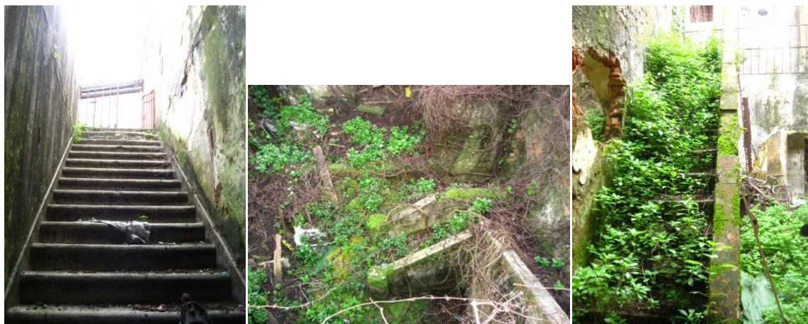
Figura 075, 076 e 077 – Fotografias das restantes escadas do edifício. (Fonte: Foto do autor tirada no dia 2 de Fevereiro de 2011)
