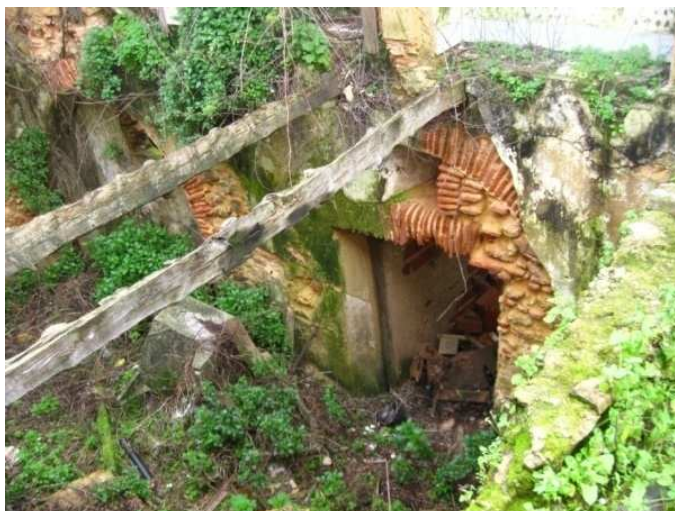
Figura 113 – Estrutura de pavimentos existente no primeiro piso na ala a ponte. (Fonte: Foto do autor tirada no dia 1 de Fevereiro de 2011)
