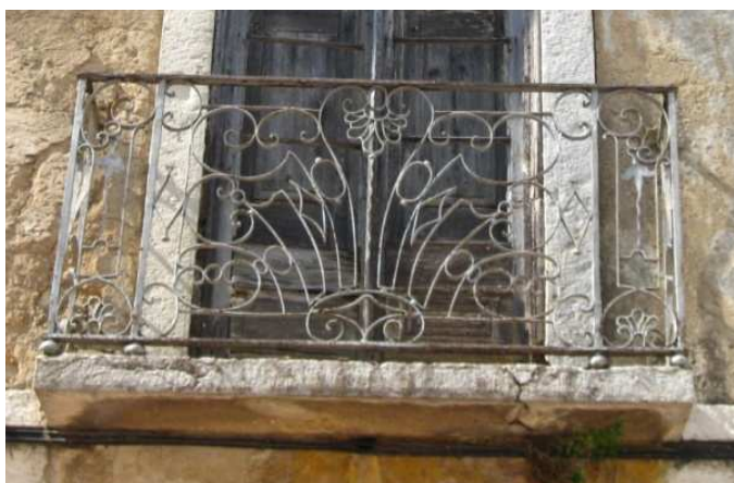
Figura 089 – Fotografia de uma Guarda existente na Fachada Principal. (Fonte: Foto do autor tirada no dia 2 de Fevereiro de 2011)
