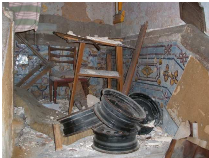
Figura 131 – Lambrim de azulejo existente no hall de entrada principal. (Fonte: Fotografia fornecida pelo actual proprietário, Eng.º Pedro Novais.)
