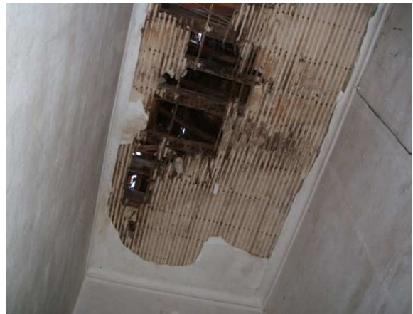
Figura 107 – Revestimento de estuque sobre ripado de madeira.
