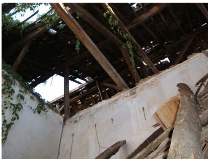
Figura 073 – Fotografia de uma asna da cobertura principal do edifício. (Fonte: Fotografia fornecida pelo actual proprietário, Eng.º Pedro Novais.)
