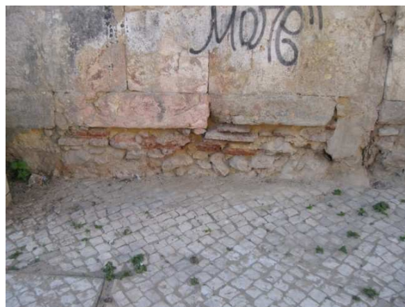
Figura 110 e 111 – Fundações parcialmente visíveis. (Fonte: Foto do autor tirada no dia 2 de Fevereiro de 2011)
