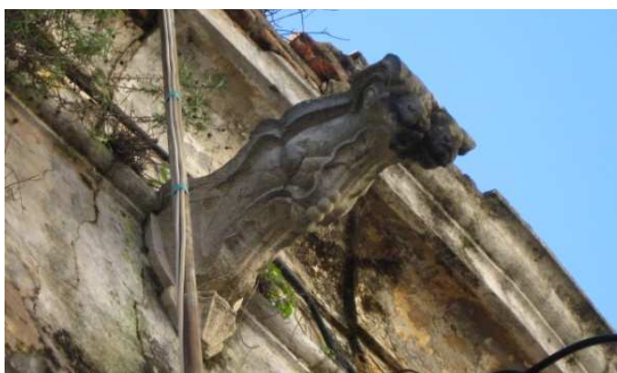
Figura 091 – Fotografia de uma das gárgulas existentes na fachada principal. (Fonte: Foto do autor tirada no dia 2 de Fevereiro de 2011)
