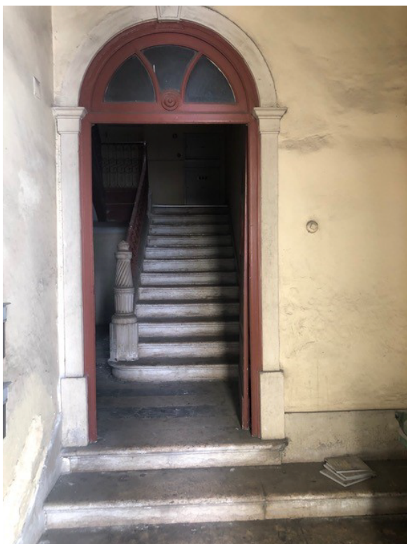
Figura 48. Rua Serpa Pinto, 5; aspeto do átrio de entrada e do primeiro lance das escadas.
