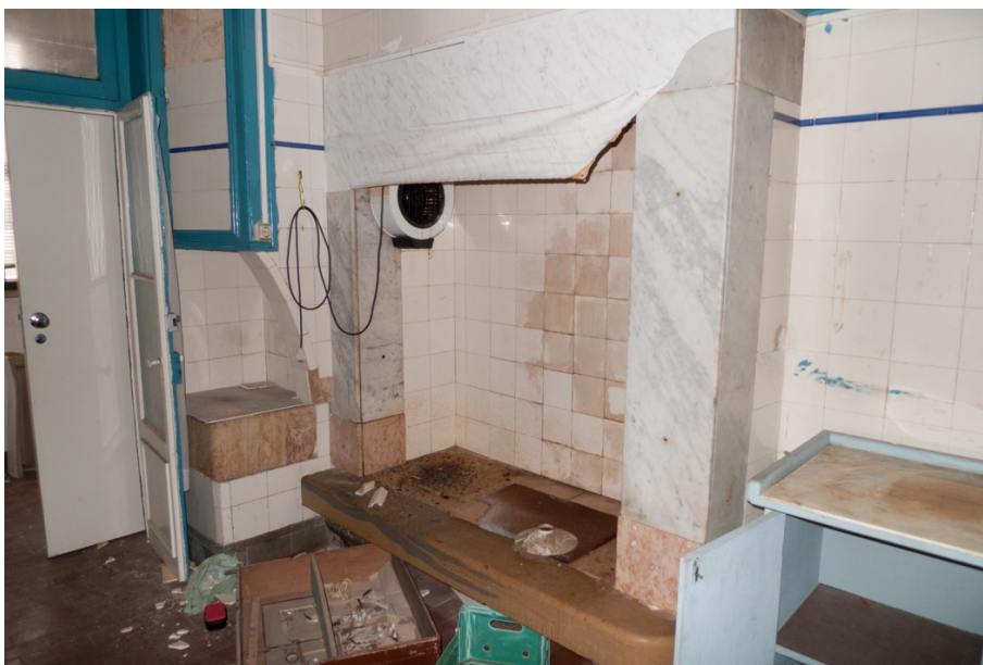
Figura 62. Rua Serpa Pinto, 5; Aspeto de lareira modificada, com recobrimento das cantarias originais.
