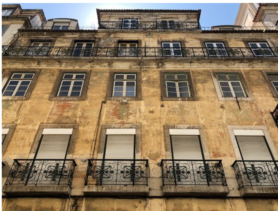
Figura 59. Rua Serpa Pinto, 5; Aspeto dos vãos exteriores na atualidade: são visíveis vãos de sacada no primeiro andar e vãos de peito no segundo andar; o terceiro andar volta a apresentar vãos de sacada que abrem para uma varanda.
