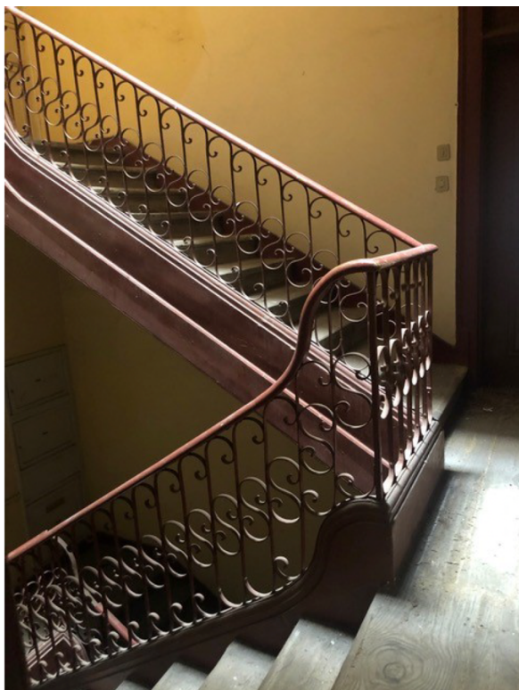
Figura 49. Rua Serpa Pinto, 5; aspeto da caixa de escadas nos pisos elevados com bomba e balaustrada de ferro forjado.
