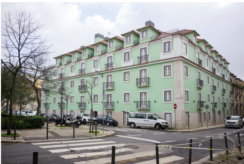
Figura 73. Edifício no Largo do Mastro, 1 a 10; após a obra de reabilitação.
