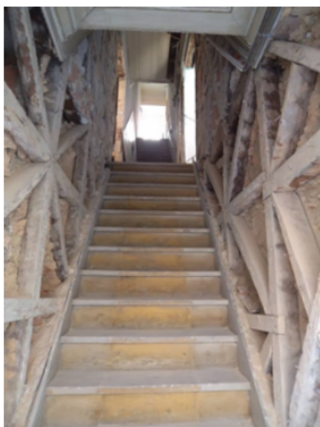
Figura 46. Esquema da estrutura das escadas dos prédios pombalinos (Appleton, 2011, p. 351).
