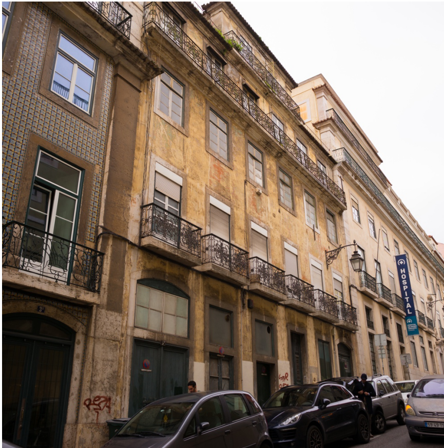
Figura 17. Rua Serpa Pinto, 5; Fachada principal.
