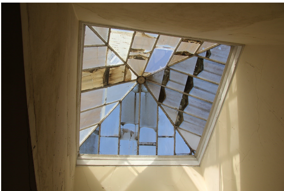
Figura 56. Rua Serpa Pinto, 5; Pormenor do lanternim ou claraboia de iluminação da caixa de escadas.
