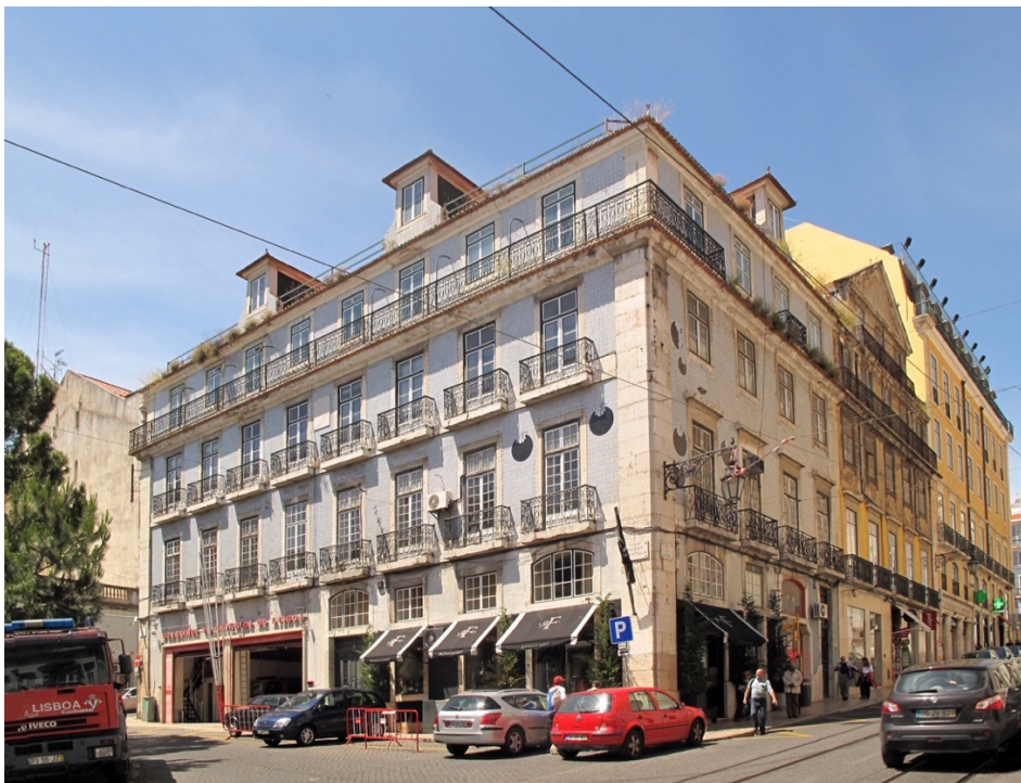
Figura 66. Quarteirão delimitado pela Praça Luís de Camões, Rua do Alecrim, Largo do Barão de Quintela e Rua das Flores; situação antes da obra.
