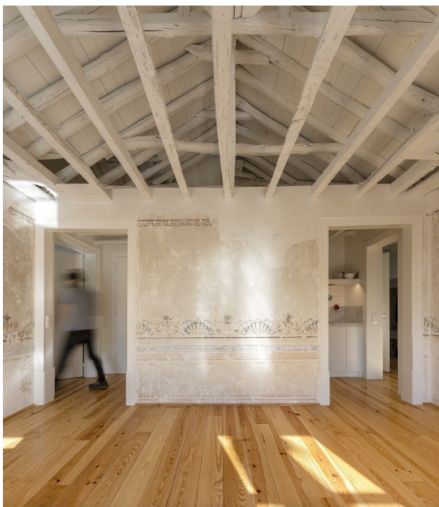
Figura 75. Edifício na Rua dos Douradores, 186-196 e Rua de Santa Justa, 10-16; sala no último piso.
