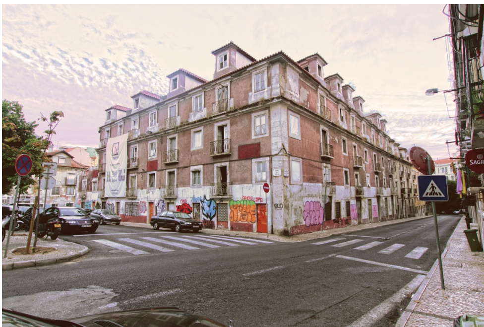
Figura 72. Edifício no Largo do Mastro, 1 a 10; situação antes da obra.
