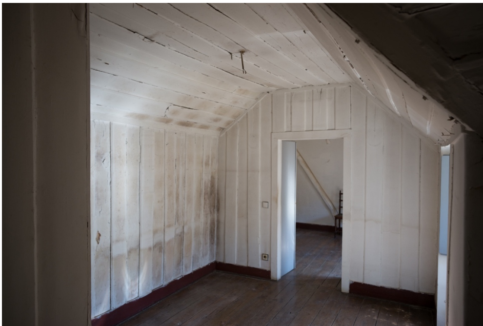
Figura 24. Aspeto das águas furtadas de um prédio pombalino na Rua Augusto Rosa, em Lisboa.
