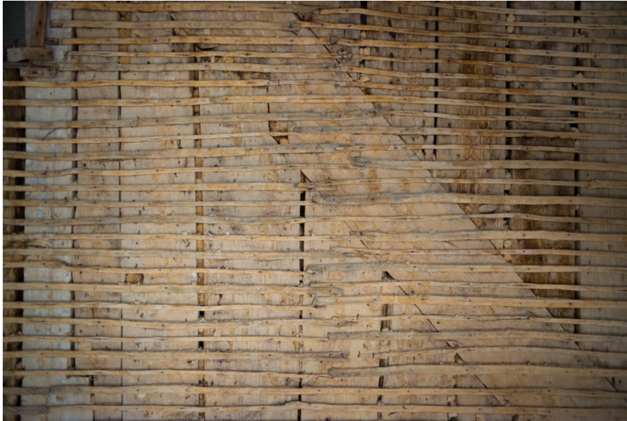
Figura 29. Parede de tabique em prédio pombalino na Rua da Emenda.
