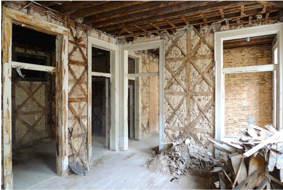
Figura 28. Paredes de frontal em prédio pombalino na Rua do Arsenal, em Lisboa.
