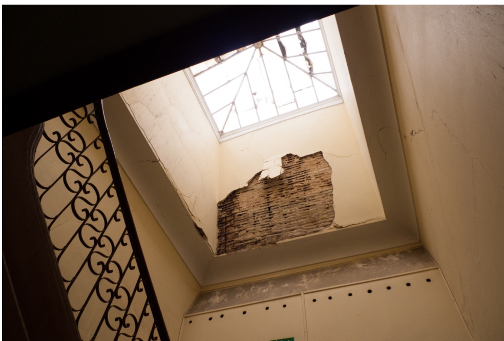
Figura 55. Rua Serpa Pinto, 5; Lanternim ou claraboia de iluminação da caixa de escadas.
